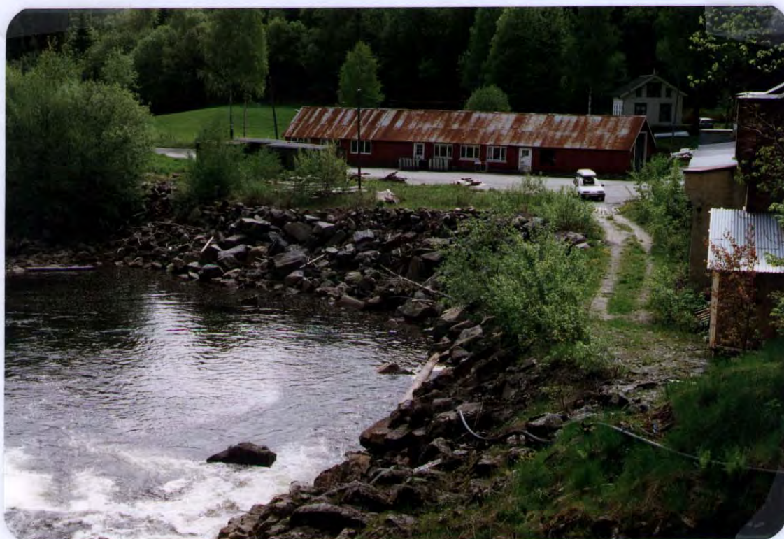
Figur 16. Fosstveit industriområde, Tvedestrand kommune. Til høyre skimtes deler av det gamle tresliperiet. Midt i bildet vises steinfyllingen som er lagt ut som forbygning mot elva.
