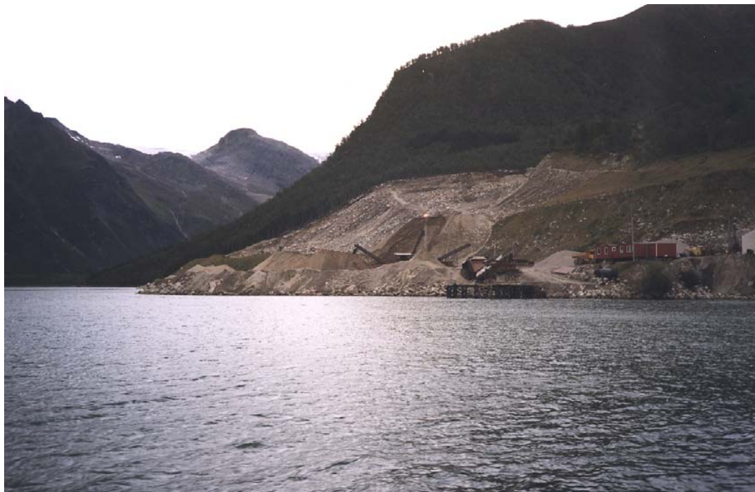
Figur 2. Sanduttaket til Nordland Betong A/S sett fra nordvest.
