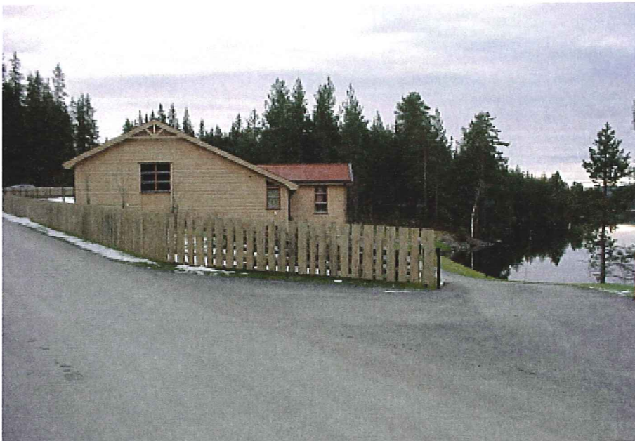
Skjelbreia vannverk i Vestre Toten kommune
