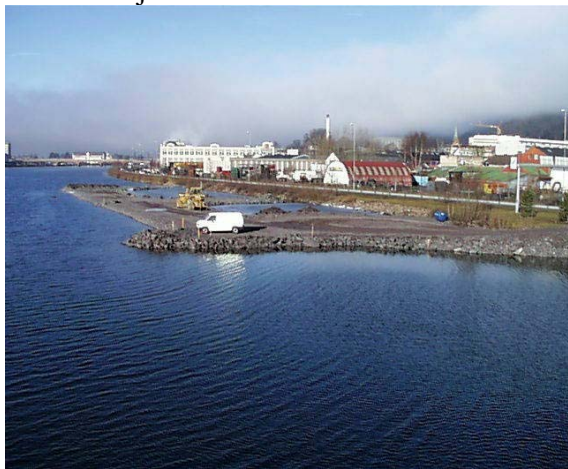
Park 2 oppstrøms Holmen bru
