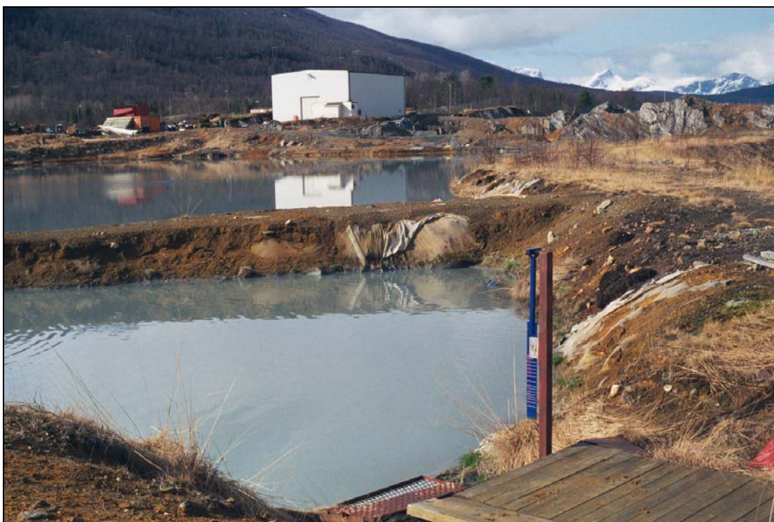
Figur 1. Klaredam for avslamning av gruvevann
