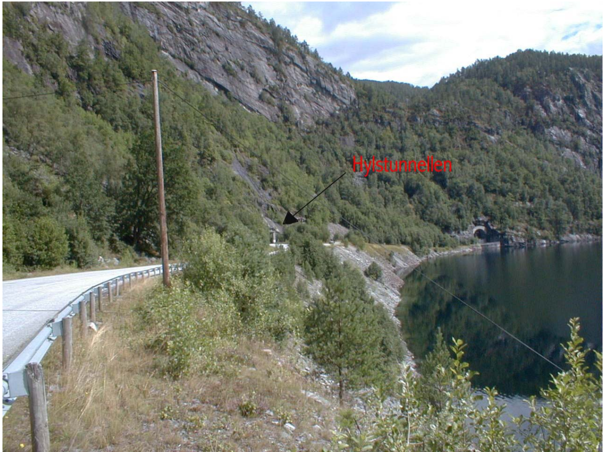
Figur 5. Fyllingsområdet ved Djupevik sett mot nord-øst. Hylstunnelen og inntakstunnelen til Hylen kraftverk til høyre, stolpe for telekabel til venstre på bildet. (Foto: Magne Bratland).
