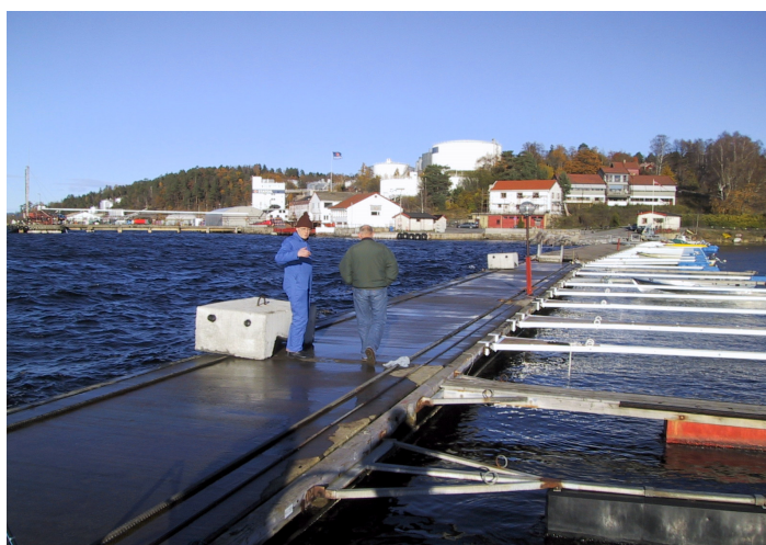
Figur 3. Fotografier fra båthavna 1. november 2001. Øverst: sett mot SE, retning badestranda og elva. Midten: Fra ytterste rekke av flåter, mot nord og tankanlegget. Nederst: Nordre rekke av betongflåter.
