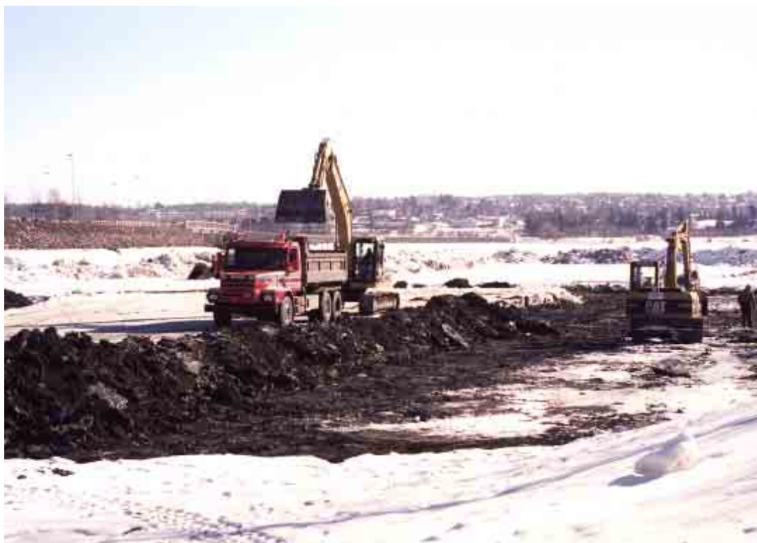
Fjerning av PCB-holdige sedimenter mars 2001 Foto: Jarl Eivind Løvik
