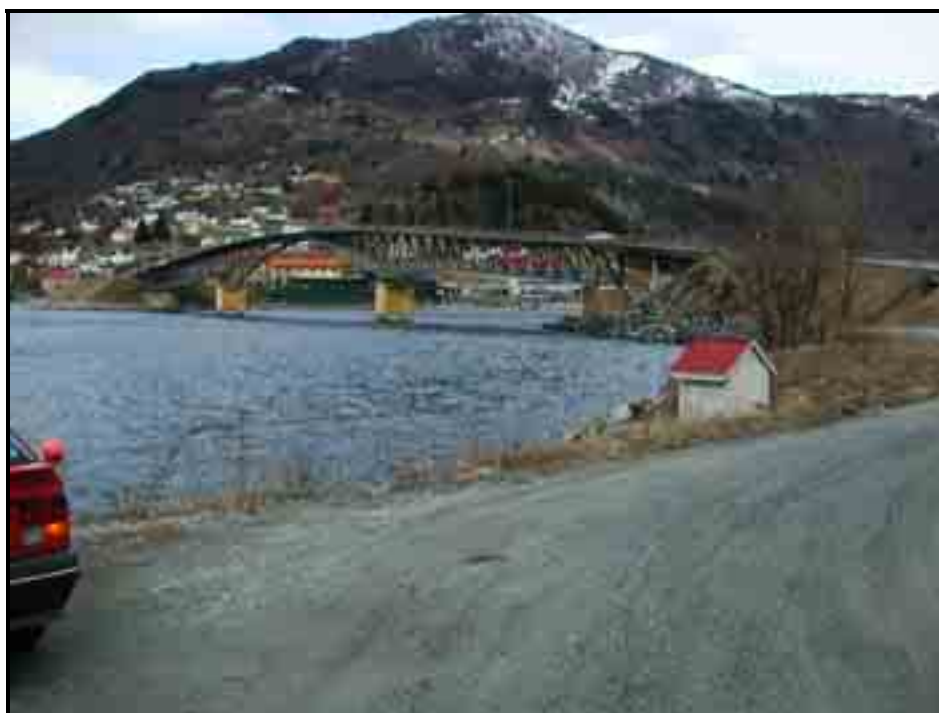
Figur 2. Loftesnesbrua, april 2003. Øvst: Sett frå Sogndals-sida. Nedst: Sett frå innfartsvegen på aust-sida (Loftenes-sida).
