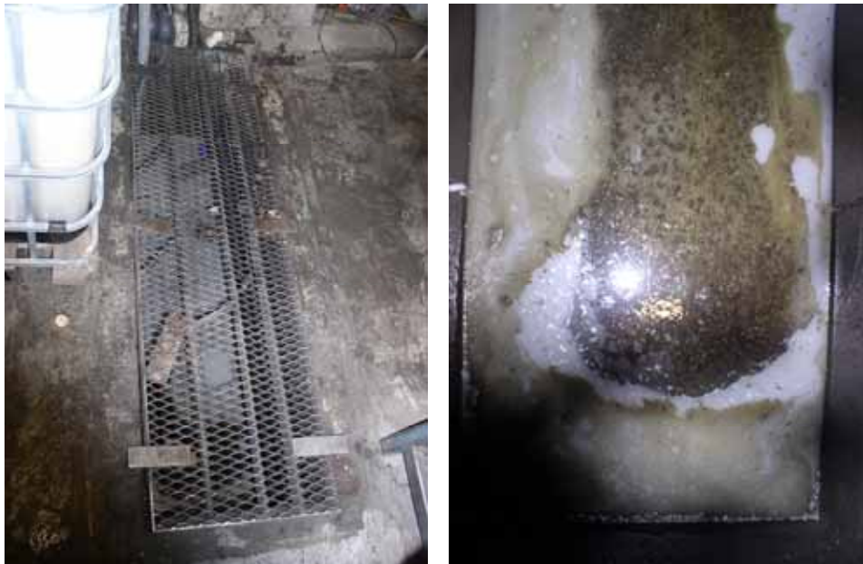
Sump. Sumpen (høyre bilde) som mottar avløp fra maskin 1 (slutten av uka), maskin 2 (daglig) og maskin 4 (slutten av uka). Nærbilde av sumpen med oljelag på toppen (høyre).
