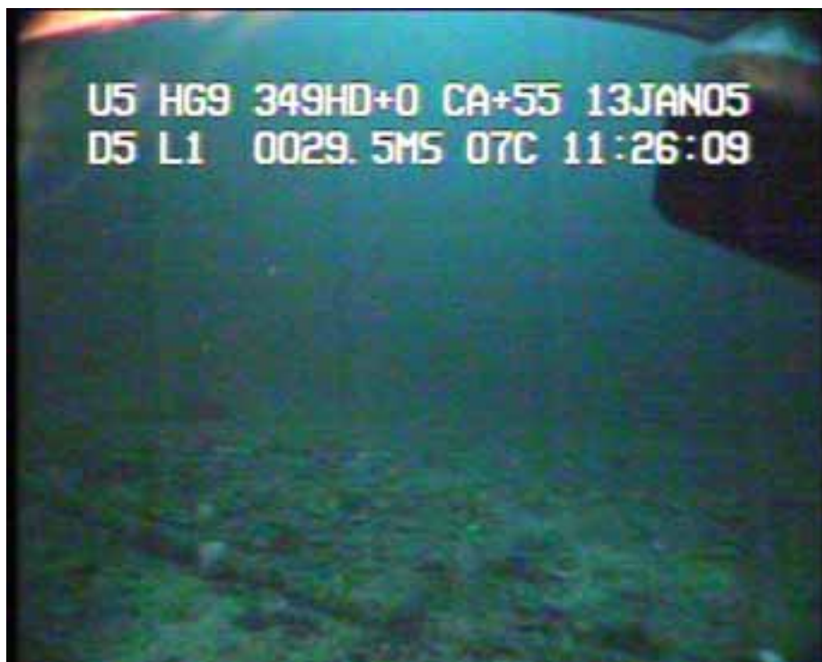
Figur 20. Transekt rett over el-kabelen om lag midt i sundet, litt sørom grunnaste partiet.
