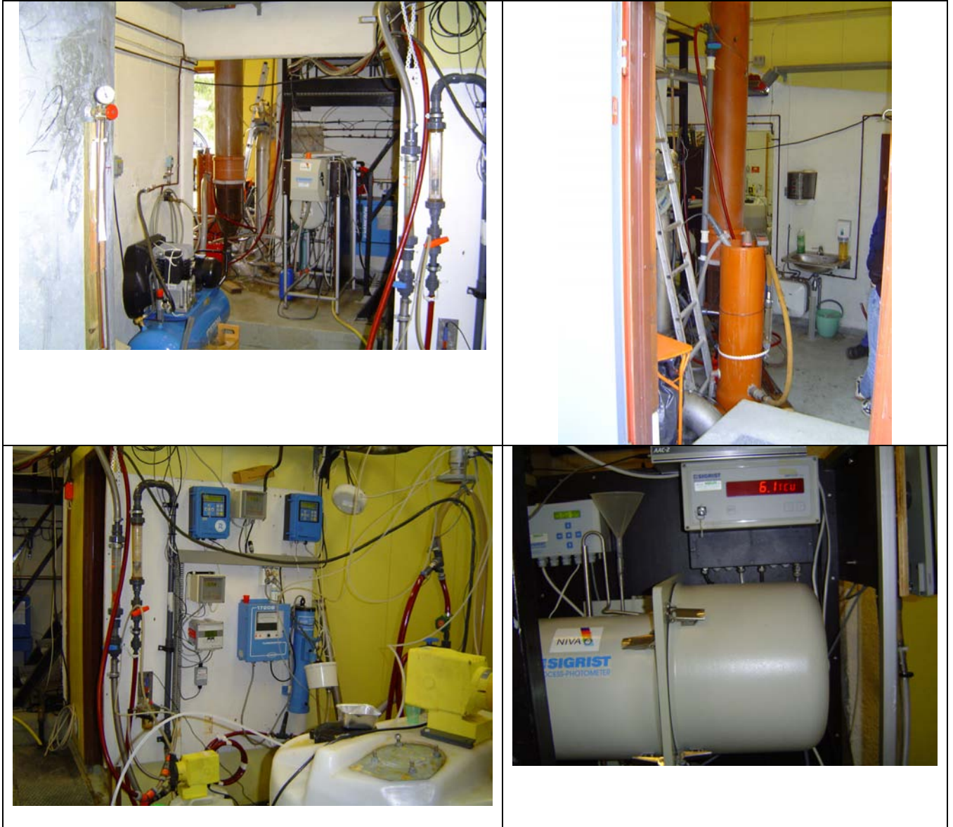
Figur 4. Foto av pilotanleggets plassering i vannverket med laveste oppnådde farge vist på fargemåleren nederst til høyre.
