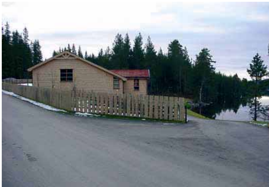
Skjelbreia Vannverk i Vestre Toten kommune
