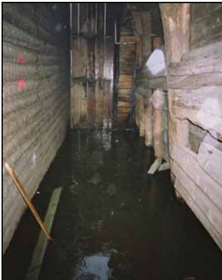
Figur 10. Fotografi frå dråpefallet ved nordsida av Bredsgården under springfloa 12. januar 2005. fotografiet er tatt bakfrå, i retning Vågen. Vannstanden i bygningsfronten var ca ½ m. Ein av NIVAs måleinstrument (posisjon C, SD200 sonde) var plassert her.
