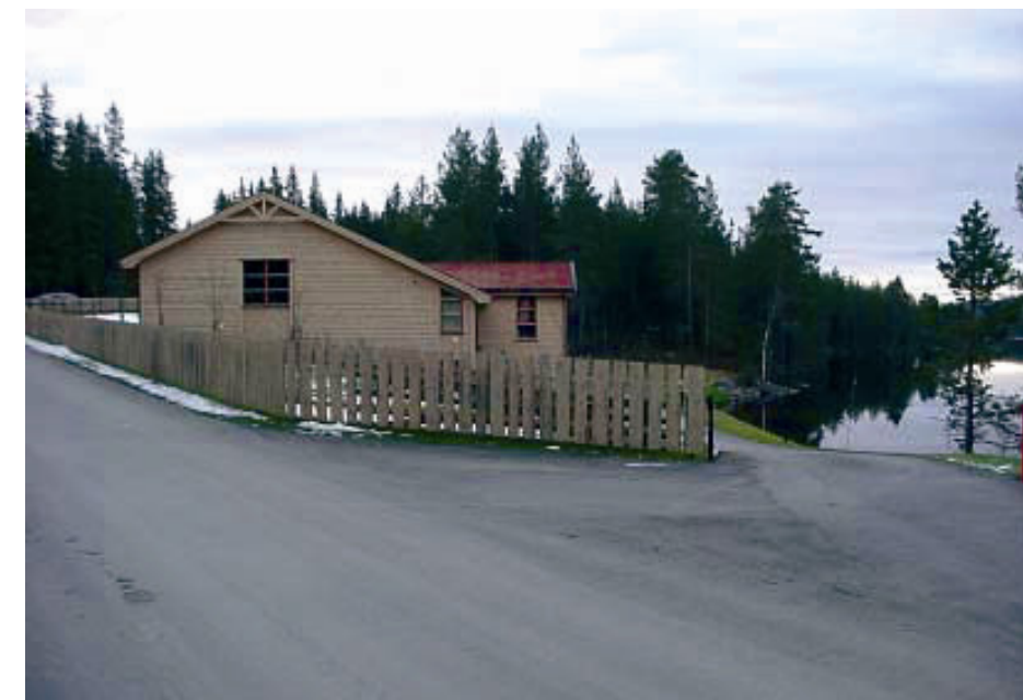
Skjelbreia Vannverk i Vestre Toten kommune
