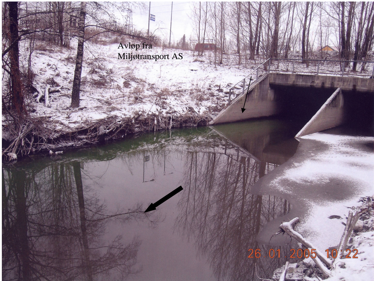
Figur 2. Tracerforsøk for å se på innblanding mellom stasjon 1 og 2. Utslippet er synlig ved borte del av kulvertavløp (grønn farge) og er indikert med smal pil. Bred pil indikerer vannstrømmens retning.
