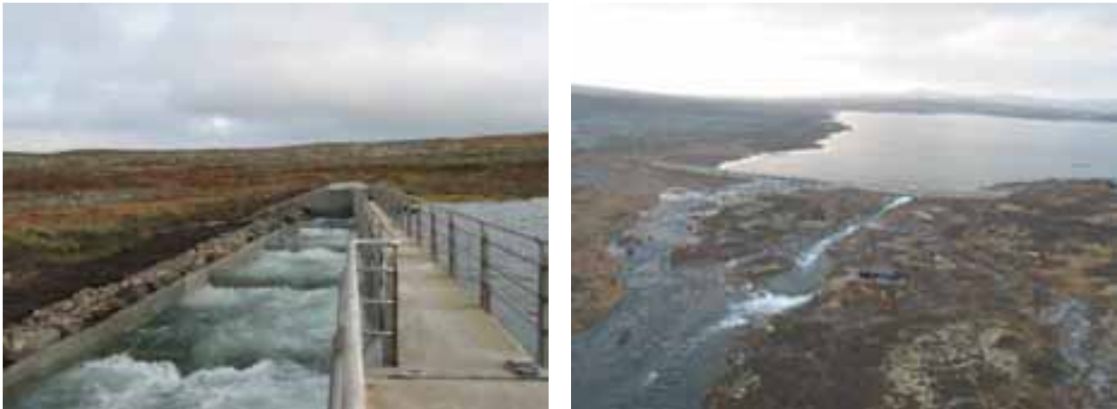
Figur 11. Fisketrappen i Halnefjorden. På bildet til høyre sees også ledemuren (midten av bildet) som skal lede ørreten opp fisketrappen. Foto: Numedals-Laugens Brugseierforening.
