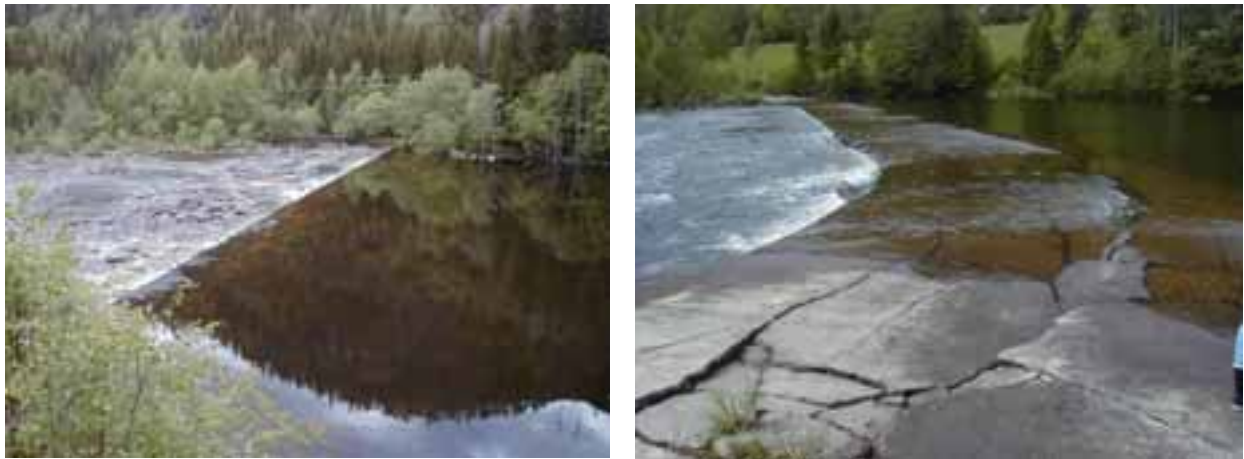
Figur 14. Bildet til venstre viser gammel spuntterskel ved Skjønne, mens bildet til høyre viser gammel kjøreterskel ved Hvammen. Begge foto: Numedals-Laugens Brugseierforening.
