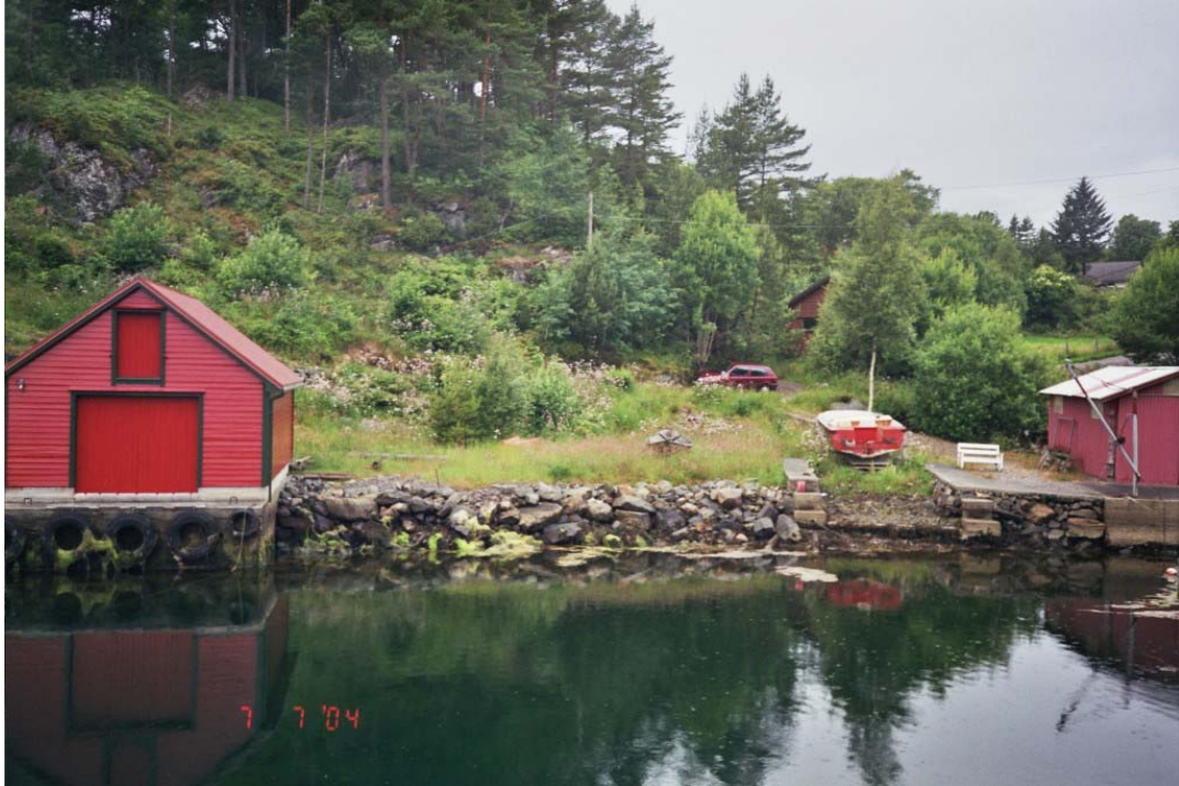
Figur 2. Fotografi tatt 7. juli 2004 mot vest i Eidespollen med den forrige rensestasjonen (hus bak trea midt på biletet). Den gamle utsleppsleidingen gjekk i sjøen om lag midt på biletet.
