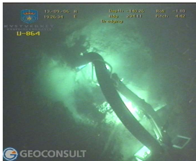
Figur 20. Sugemudring av rene sedimenter
