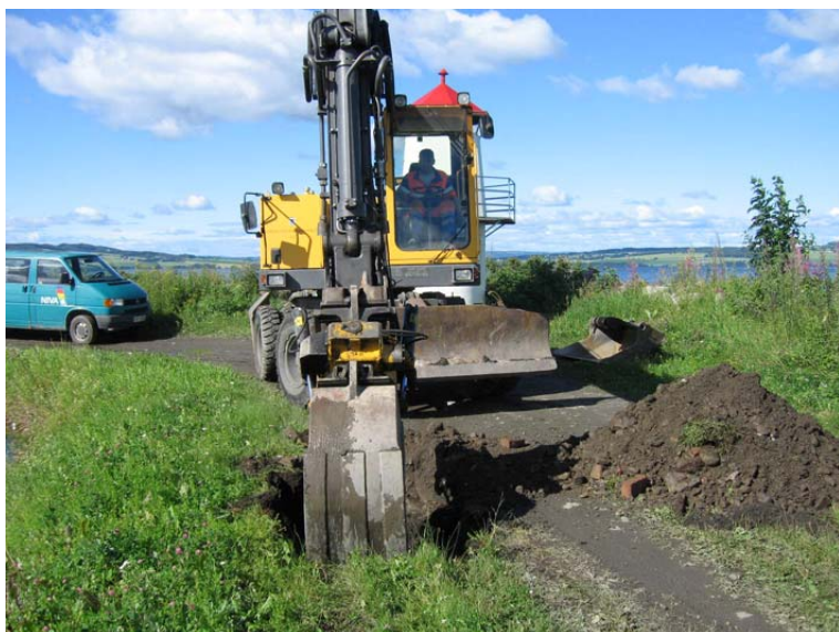
Figur 2. Oppgraving av masse for prøveinnsamling fra moloen ved prøvestasjon 7.
