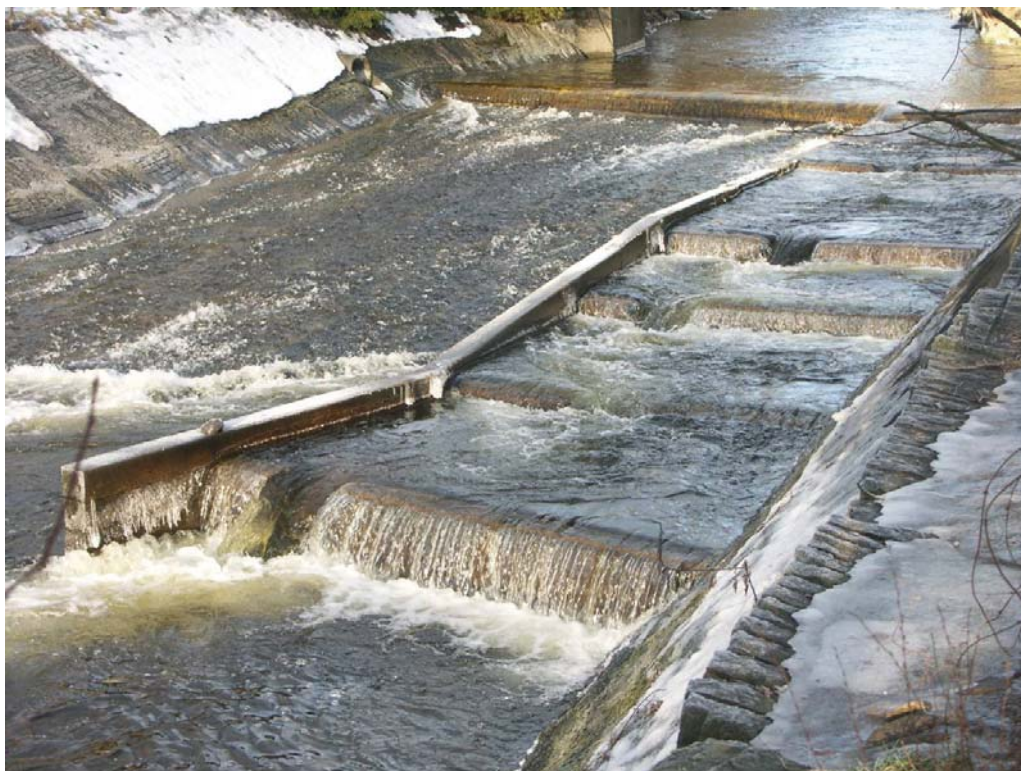
Figur 19. Fisketrappa ved Nybrua.
