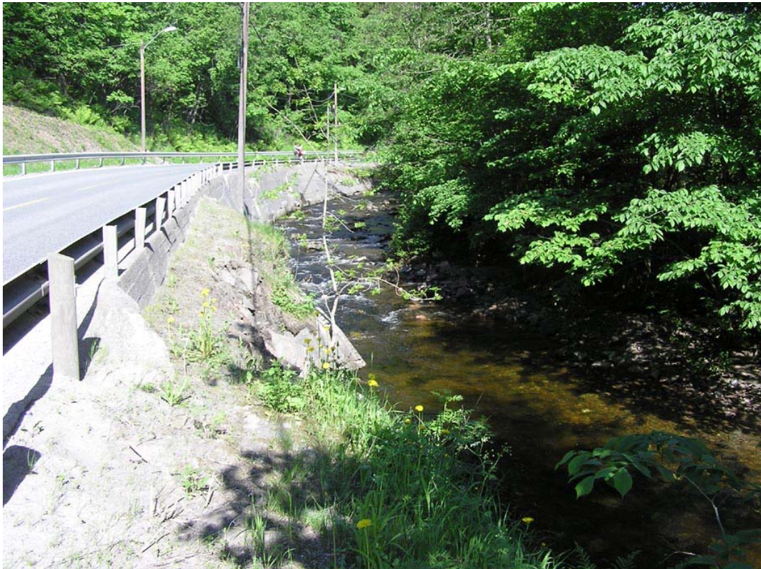
Figur 13. Kanalisert strekning. Evjene konstrueres på motsatt side av E16.
