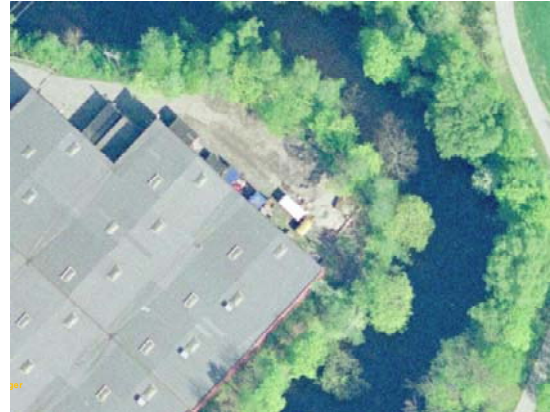
Oppfylling og begynnende utglidning, Hamang
