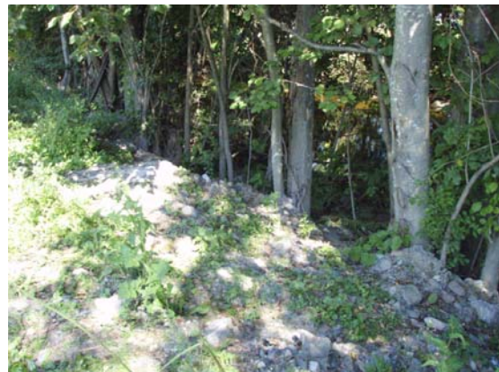
Oppfylling/utfylling mot elva
