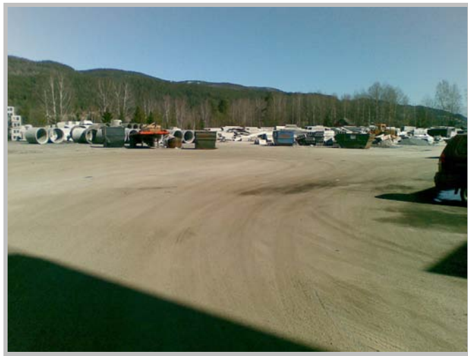
Figur 5. Asfaltert lagerområde for betongelementer. Det er betydelig trafikk av lastebiler og maskiner på området og betongbiter som skalles av de nystøpte produktene blir knust til kalkrik sand og "søle" (ses tydelig på bildet) som vaskes ned i overvannssystemet, bl.a. ved regnvær.
