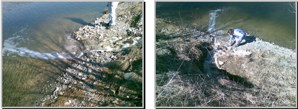
Figur 6. Det vestre utslippet til Drammenselva fra Loe Betongelementer. Utslippsvannet skummer og det er hvite kalkavsetninger i bekken og et par meter ut i Drammenselva. Visuelt ses et lysere sediment ca 2-3 m ut for utslippspunktet som strekker seg 5-6 m nedstrøms. Det østre utslippet er tilsvarende.
