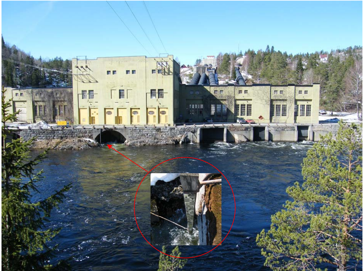
Figur 10. Foto av Bøylefoss kraftstasjon med avmerking av vannstandsstaven. På bildet vises også de fire utløpene fra åtte generatorer på kraftstasjonen. Ikke alle er nødvendigvis i drift samtidig. Derfor må installasjon(e) for nøddosering fra bil monteres slik at kalk alltid blir dosert inn i fossende vann selv om noen av utløpene er uvirksomme.
