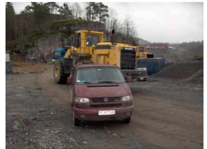
9. Oppfylte masser trafikkeres av maskiner på mer enn 50 tonn, noe som bidrar til knusing av mer stein
