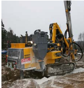
5. Blokkene splittes ved boring
