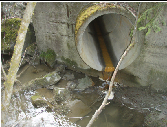
Rør under veggen fra område ved snødeponiet
