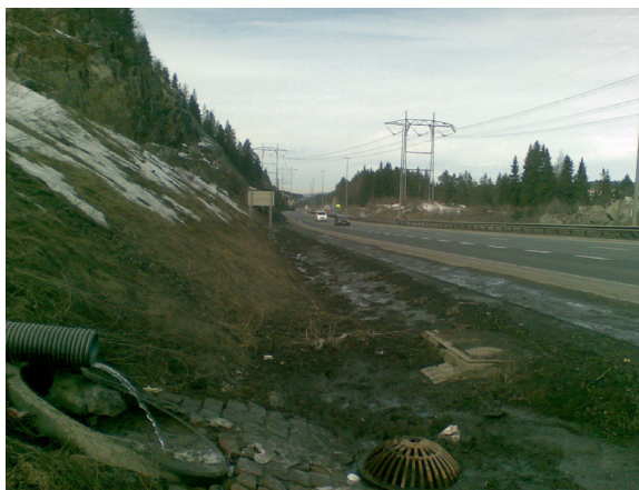
Overløpsrør i vegkanten
