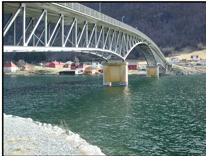
Figur 1. Loftesnesbrua i dag, sett frå Sogndalssida.
