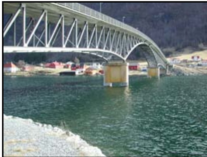
Figur 1. Loftesnesbrua i dag, sett frå Sogndalssida.
