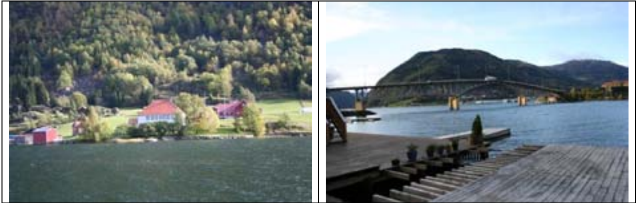
Figur 4. Foto (Ellen Njøs) tekne 5. oktober 2009 av sorenkrivargarden med utfyllinga og steinmoloen, samt av Loftesnesbrua sett frå aust (søraust) sida, i retning Sogndal.
