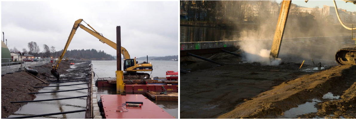
Figur 1. Sandvikselva ble mudret i perioden 25. november 2008 til 21. januar 2009. Mudringsmassene ble lagt bak en 342 m lang bentongspunt mot elveløpet som vist på bildet til venstre. Etter endt mudring ble massene STSO-behandlet på stedet, bak spunten som vist på bildet til høyre. Behandlingen var ferdig ved utgangen av januar 2009.
