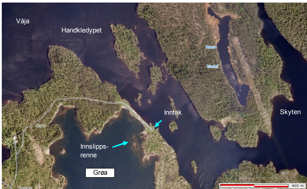
Figur 14. Vannet tas inn på ca 2 m rett utenfor lukehuset og slippes ut i en gravd renne rett på innsiden av demningen.
