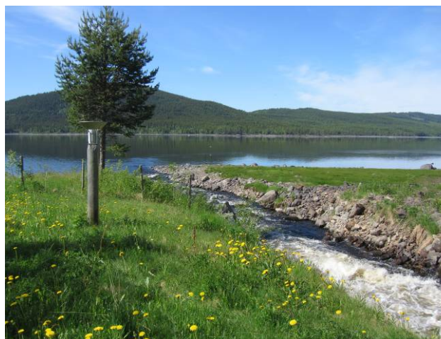
Utløpet fra Tyria kraftstasjon 17.6.2010
