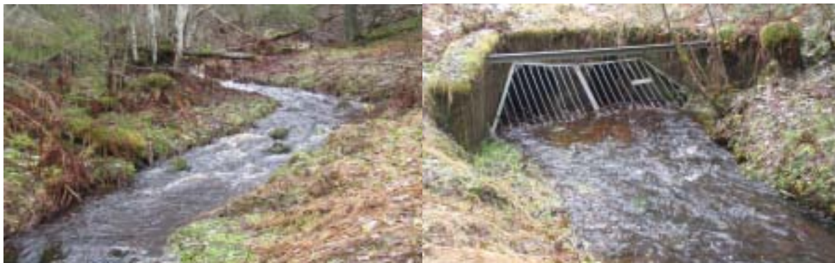
Foto: Sørå ved Kattenskoen, der bekken går i rør nedstrøms bunndyrstasjonen.
