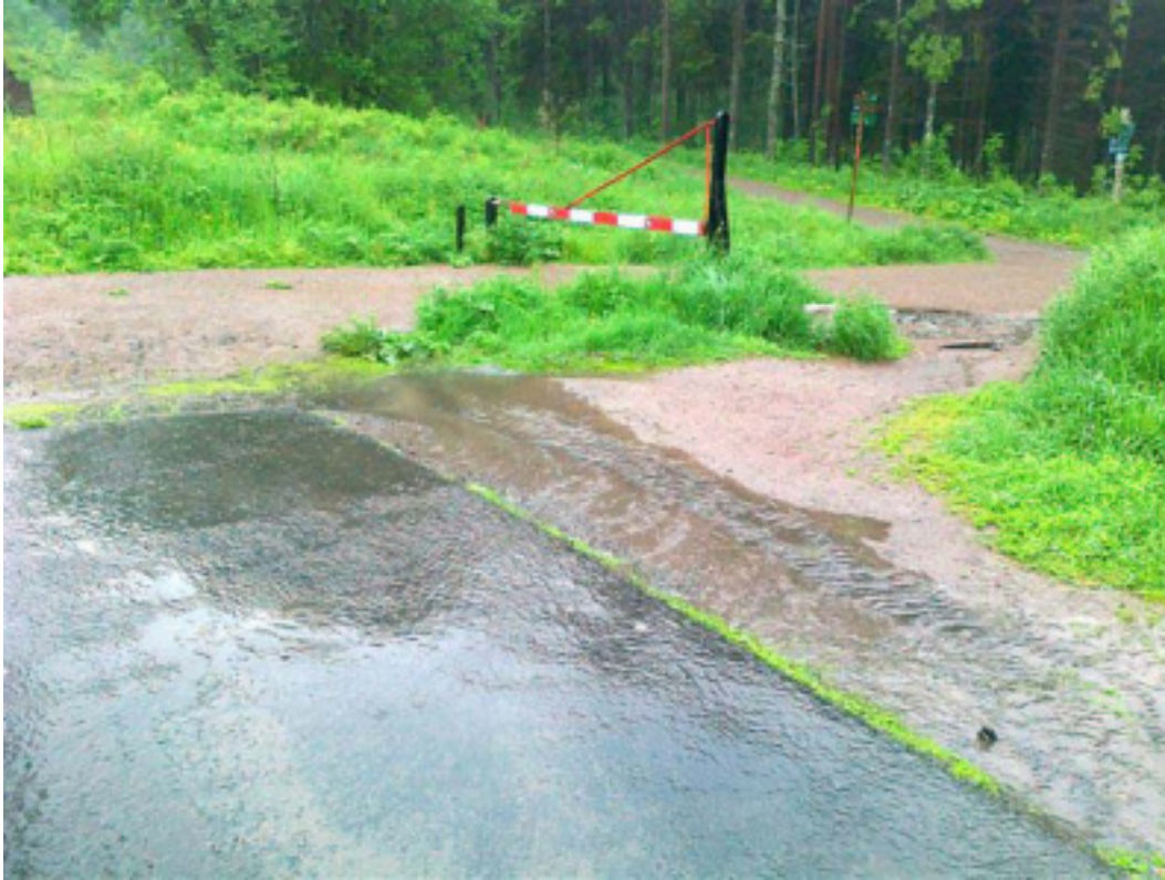
Figur 3-11. Overflateavrenning fra parkeringsplassen ved Låkeberget
