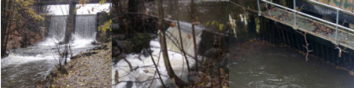
Figur 10. Demningen (t.v.), terskelen (midten) og kulverten (t.h.) i nedre del av Frognerelva. Foto: Morten A. Bergan
