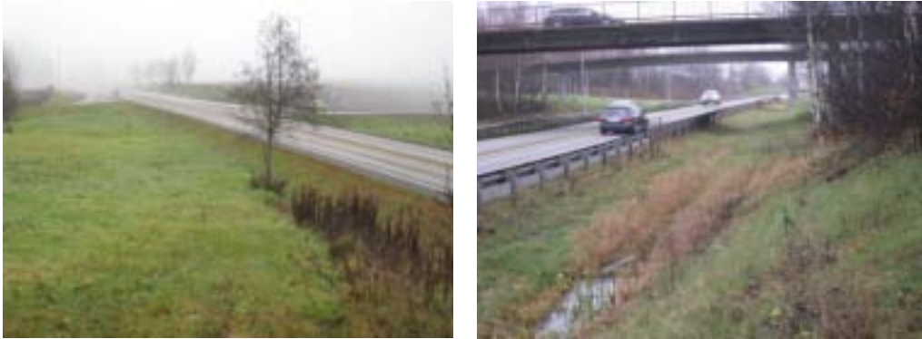
Figur 10. Grøfter og sidearealer langs E6 med potensiale for tilbakeholdelse av forurensninger ved vegetativ rensing (bioretensjon). Foto fra kryssområdet E6/Arnkvernvegen (foto: Åstebøl/COWI).
