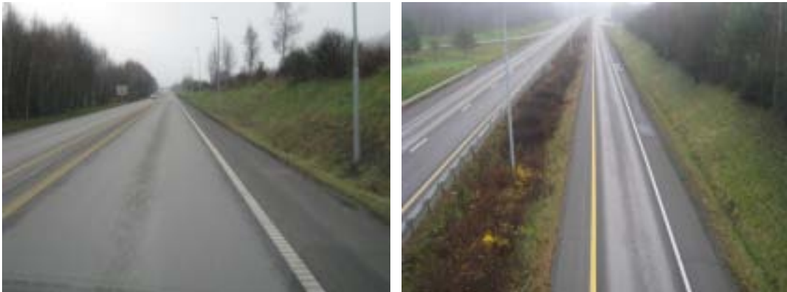
Figur 9. Utsnitt av E6-strekning, 2-felts vei til venstre og 3-felts vei m/midtdeler til høyre. Strekning med midtdeler har lukket overvannssystem (sandfang/ledninger). Sidegrøftene har avrenning via overflaten (foto: Åstebøl/COWI).
