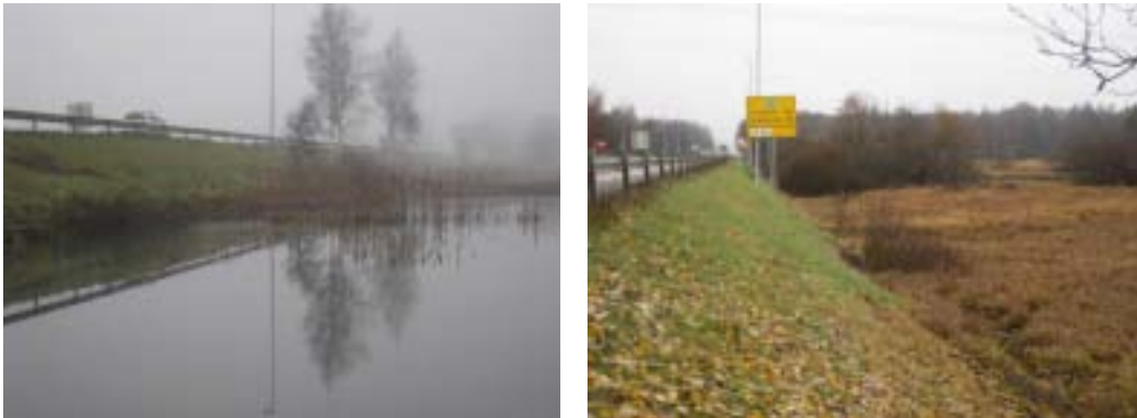
Figur 11. Deler av E6-strekningen går på fylling med avrenning til terreng/våtmark (ingen sidegrøft). Foto: E6 ved kryssingen av Åkersvika (foto: Åstebøl/COWI).
