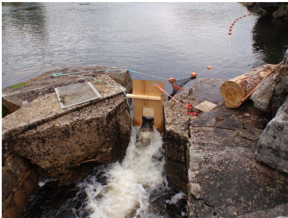
Figur 5. Åpning i laksetrappa og sperrenot på tvers av kanalinnløpet i fase 3. Foto: Å. Johansen.
