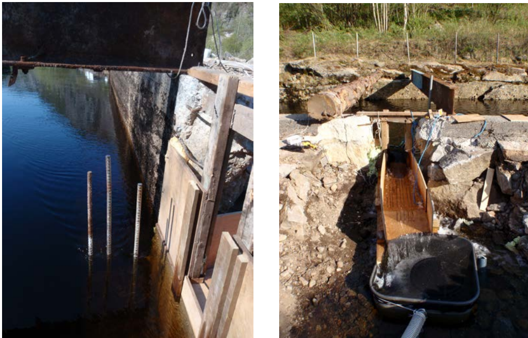
Figur 7. Hull i kanalveggen og oppsamlingskar. Foto: T. Kristensen/NIVA.
