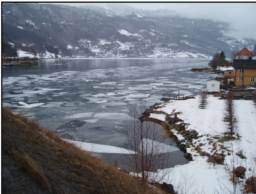
Figur 16. Døme på isoppstuving innafor ei vegfylling. Frå Barsnesfjorden, Sogndal.
