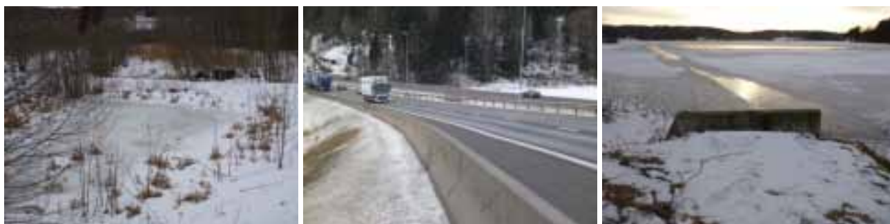
Figur 16. To rensedammer for veivann i nedbørfeltet til Årungen. Venstre bilde viser dam i sørenden av Årungen nær Korsegården. I midtre bilde ligger rensedammen mellom kjørebaneene ved Smihagan tunnel. Dammen har utløp til Årungstubbukta vist i høyre bilde (konstruksjon for utløpsledning).
