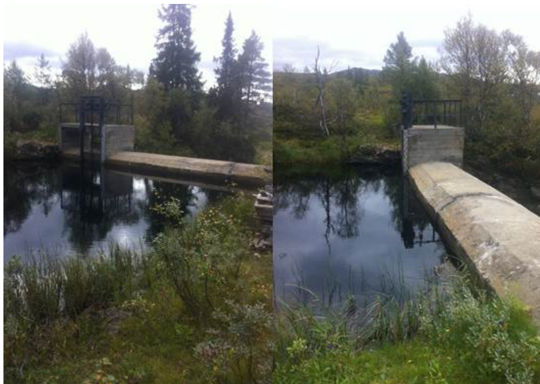
Figur 22. Demningen ved Burusjøen. (Foto: Morten Andre Bergan)
