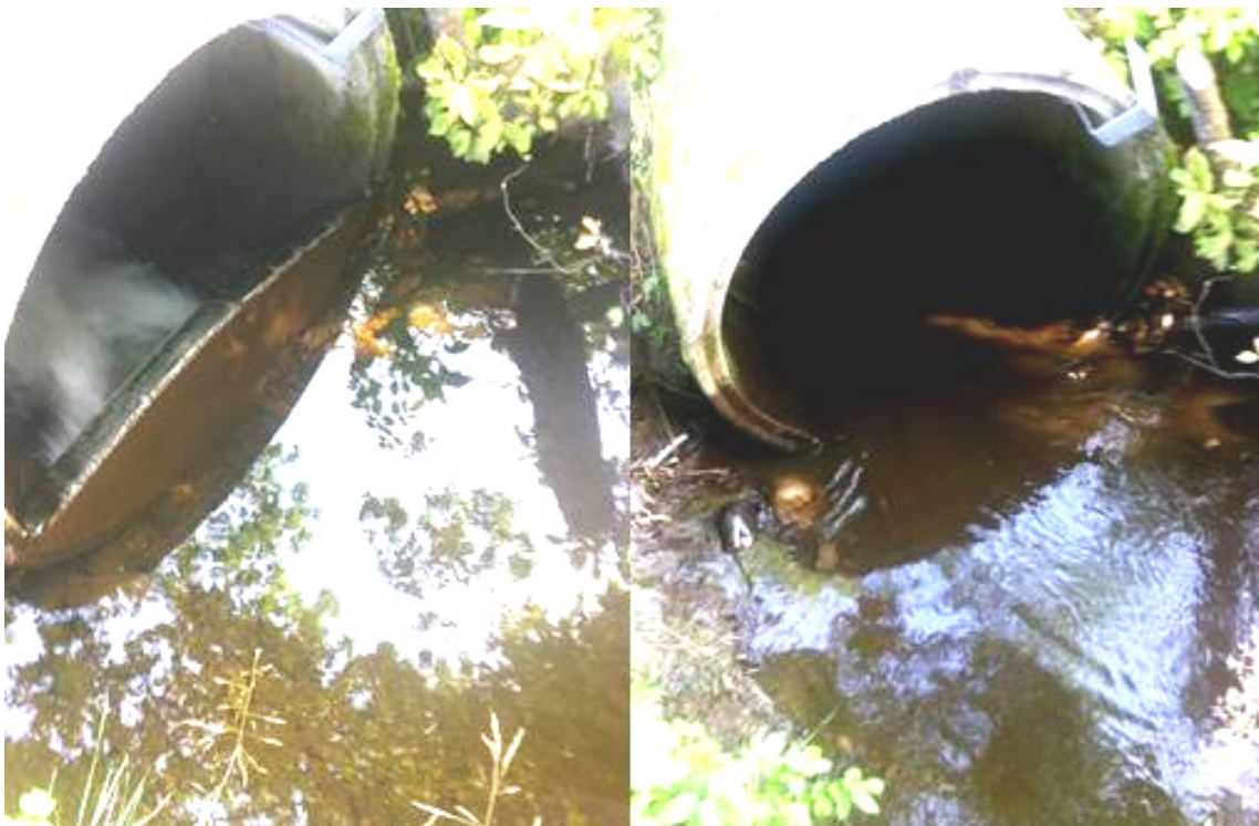
Figur 13. Sponplate satt på tvers i kulvert under grusvei (t.v.) i Skårvollbekken ble fjernet av NIVA (t.h.) slik at oppvandrende laksefisk slipper forbi. (Foto: Morten Andre Bergan)
