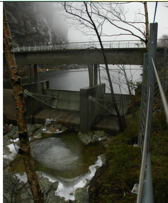
Dam Lundevatnet. Bilde tatt fra aktuell lokalitet mot Nord-Vest.
