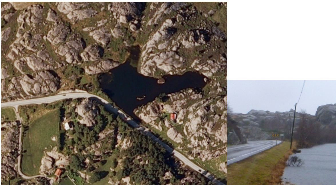
Figur 20. Veganlegget (Fv44) ved Revurstjern.
