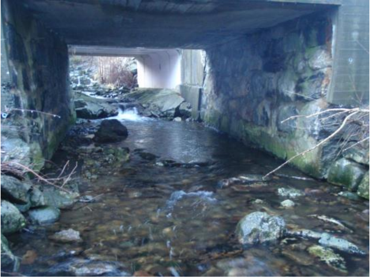
Figur 46. Krysning under E 39 i bekk ved Årek.
