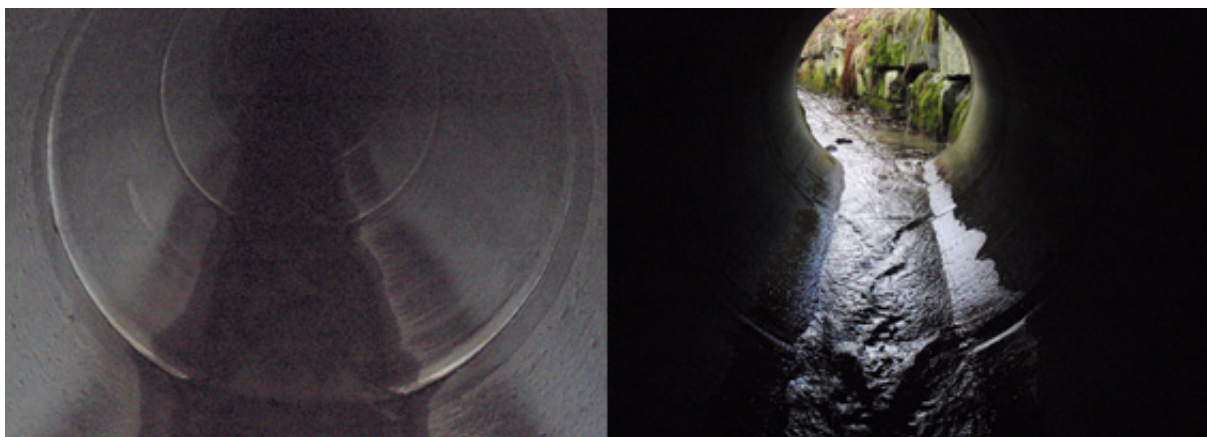
Figur 39. Inngang kulvert under E 134 i bekk ved Førre.
