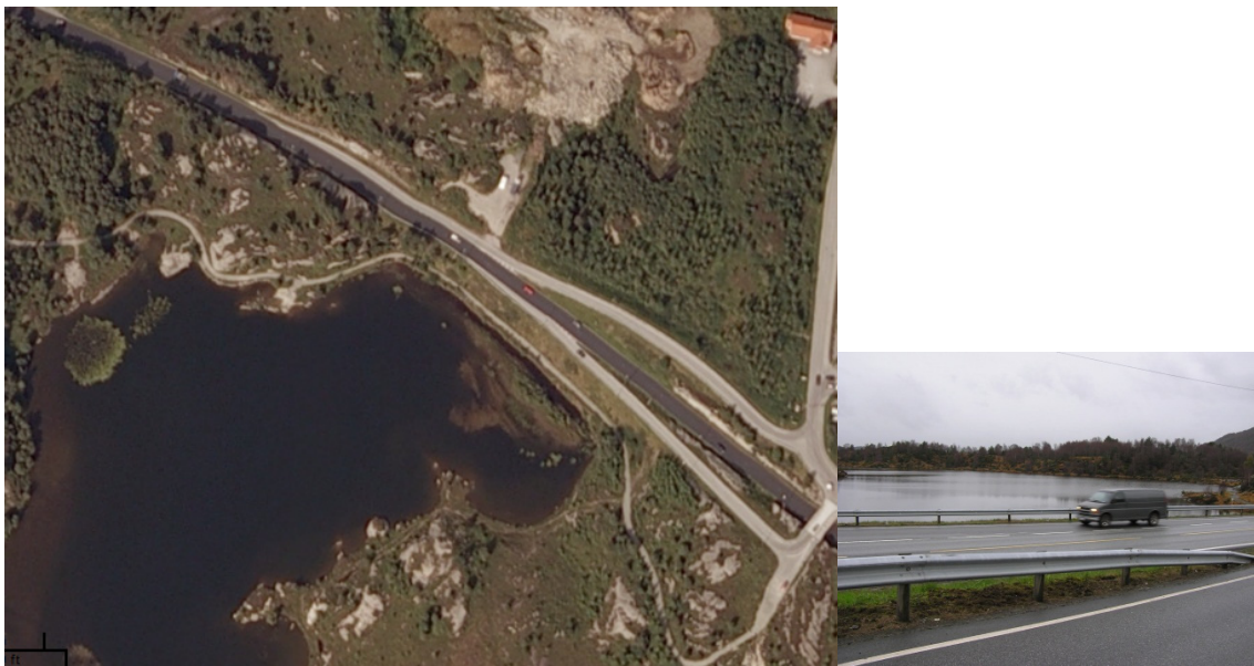
Figur 21. Veganlegg (E134) med av- og påkjøringsramper ved Bongsatjern
