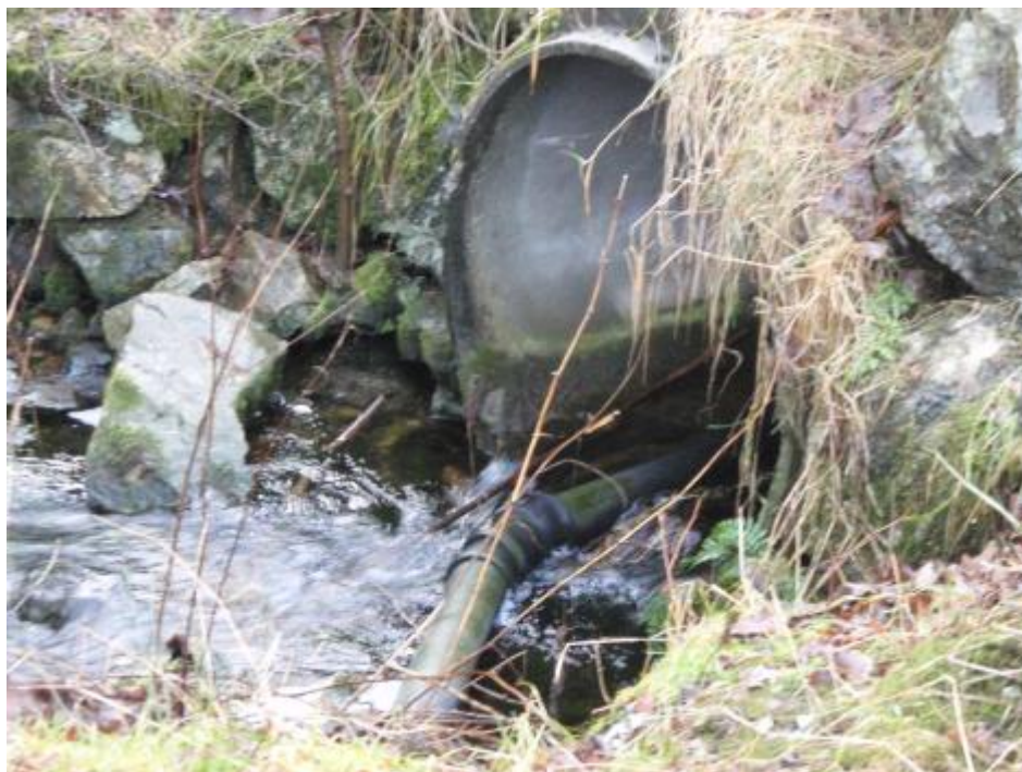
Figur 44. Krysning under Fv 831 i bekk fra Rabbavatnet.
