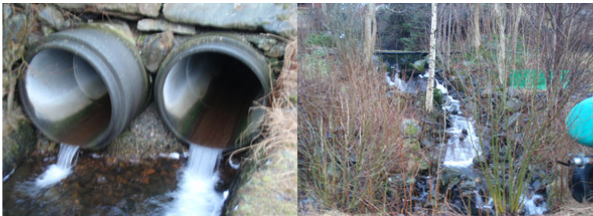
Figur 50. Hovedbekken går i vandringshindrende kulvert under privat/kommunal vei, men naturlig anadrom strekning er svært kort oppstrøms hinderet (t.h.).
