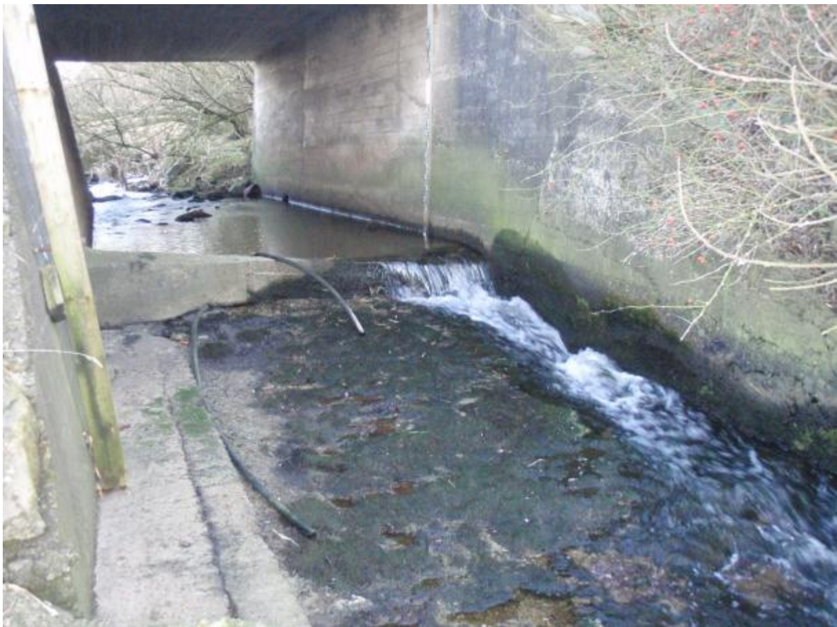
Figur 31. Kulvert under Fv 44 i Årslandsåna.
