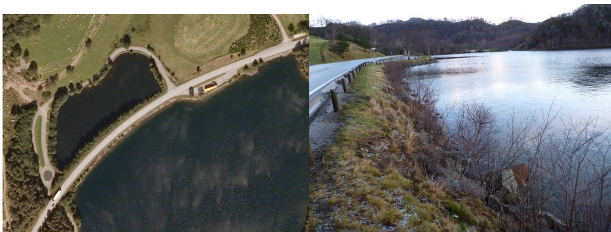
Figur 24. Avsnørt bukt i Saglandsvatnet har liten vannutskiftning. Det går et ca. 60 cm rør omkring midt i fyllingen vist som et rustent jernrør nederst til høyre i bildet (sett mot nordøst).
