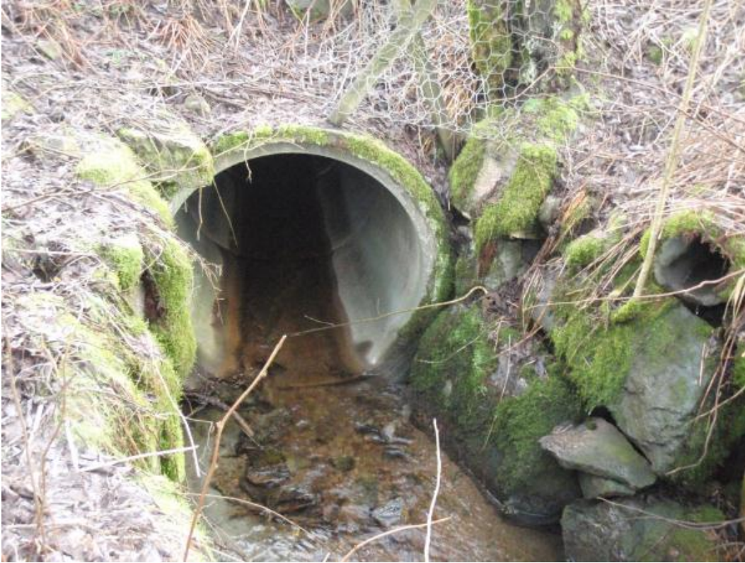
Figur 40. Inngang kulvert under E 134 i bekk ved Førre.
