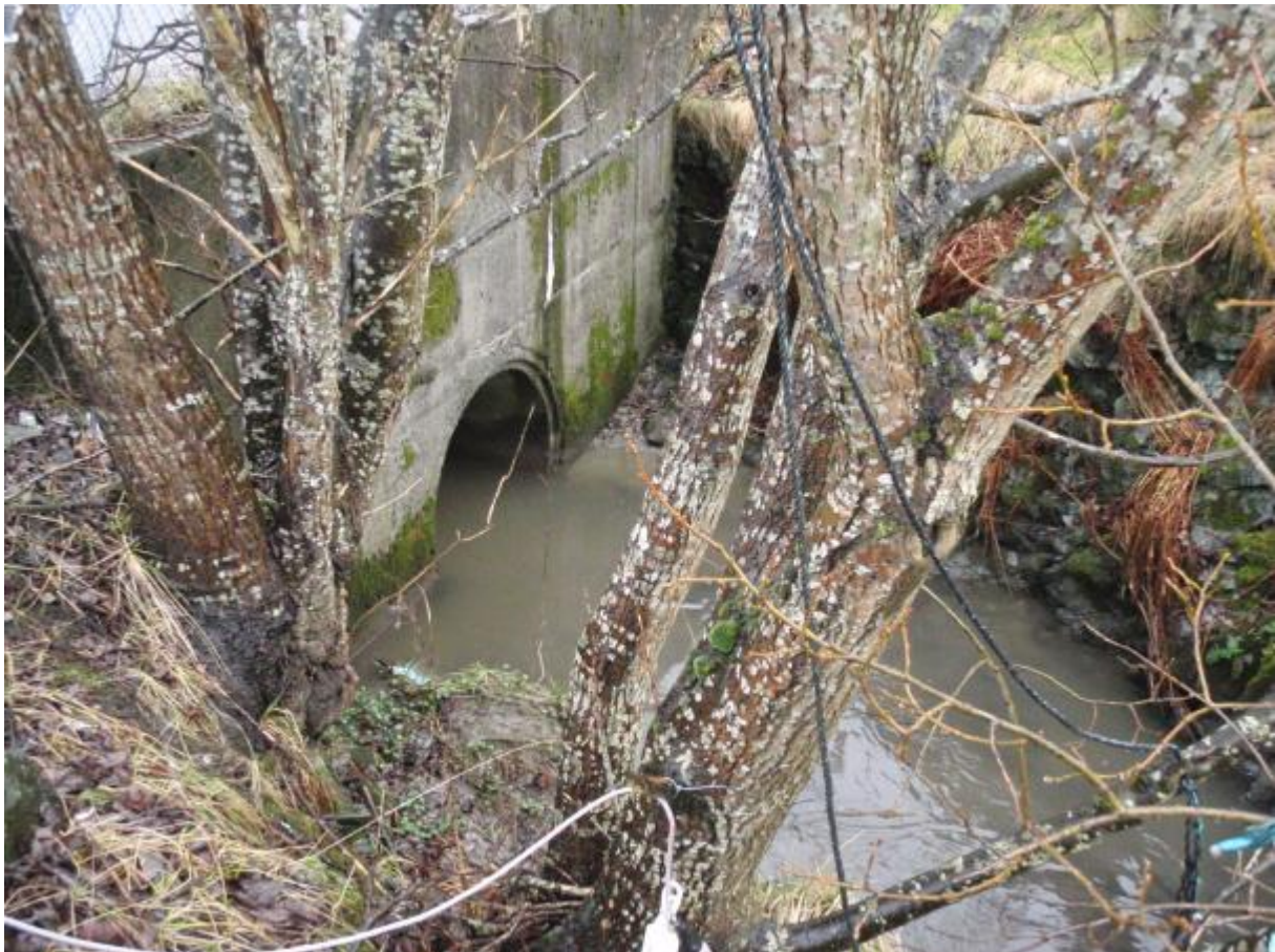
Figur 42. Krysning under Fv 831 i bekk fra Raglamyr.
