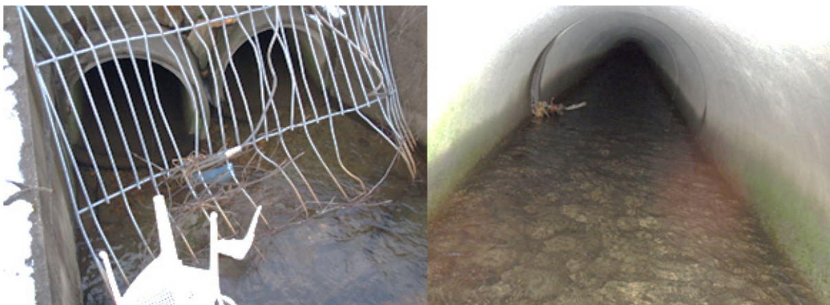
Figur 48. Innløp til kulvert som går under 542.
