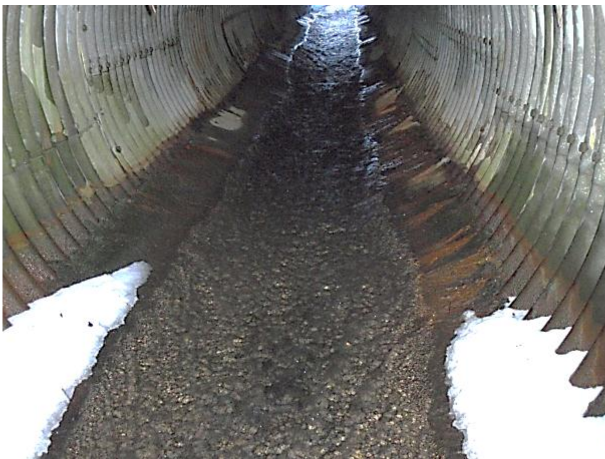
Figur 56. Betongbelagt blikk-kulvert under 39.
