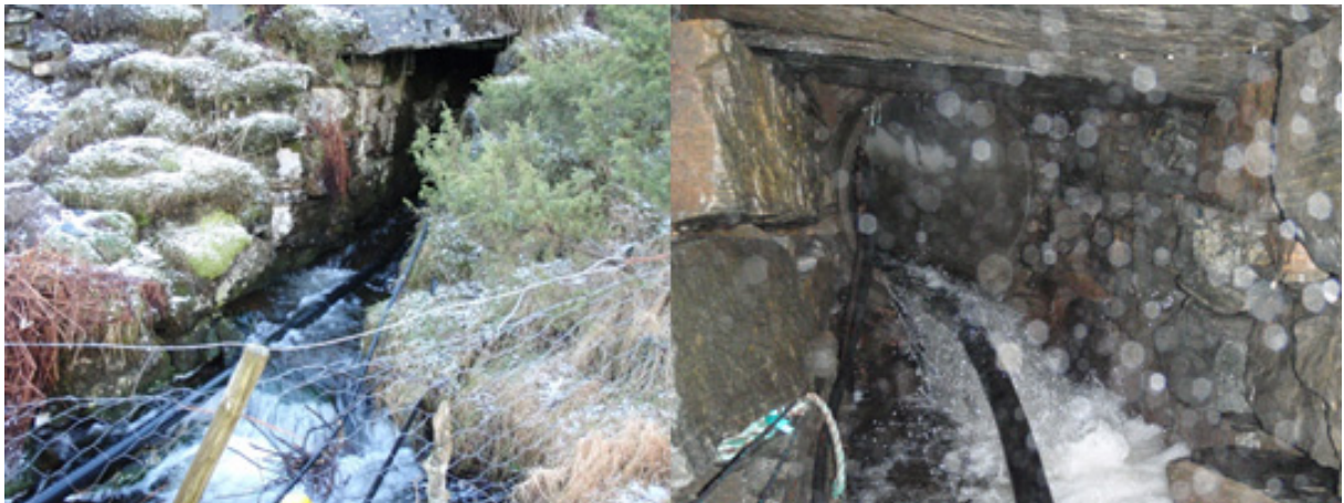
Figur 33. Kulvert under 65 ved utgang og under veien.
