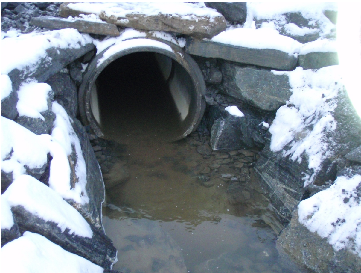
Figur 62. Utgang av kulvert.
