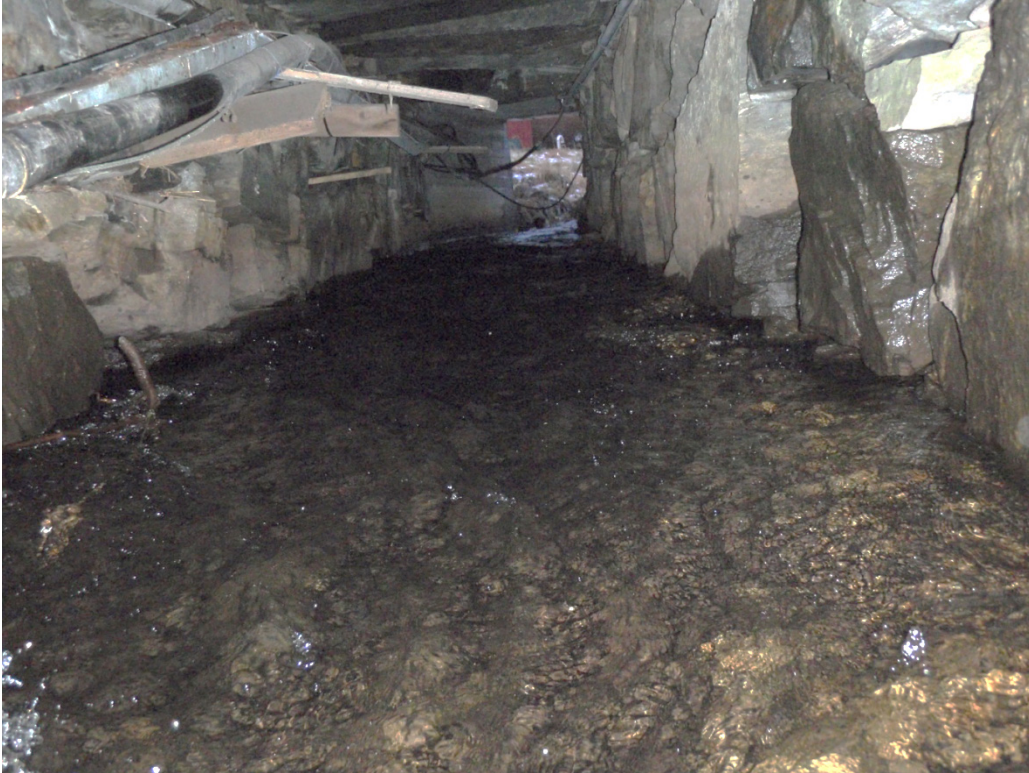
Figur 40. Foto opp mot innløp i krysning under 548.
