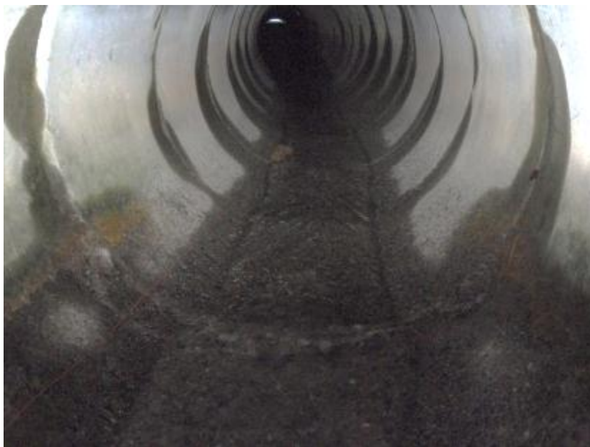
Figur 10. Innside av kulvert i bekken Vassgrovi.
