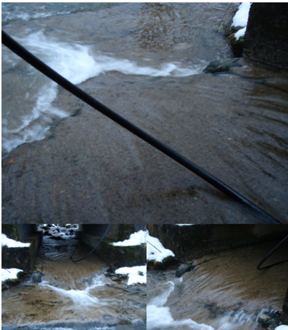
Figur 12. Betongbelagt bunn i kulvert
