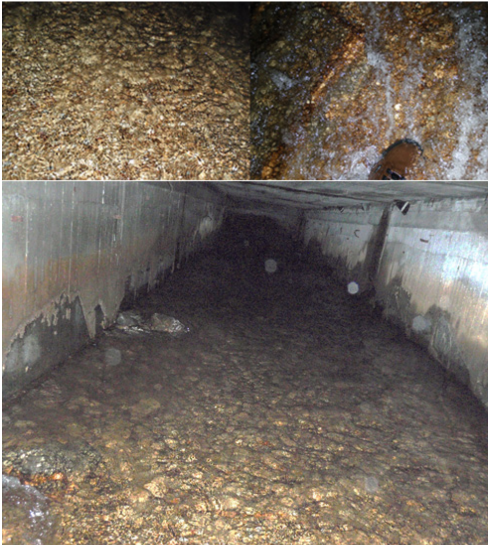
Figur 27. Overgang til murt betongbunn om lag 30 meter inne i kulverten.
