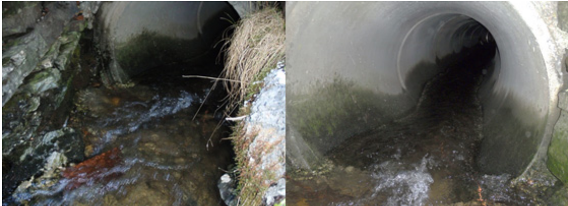
Figur 29. Innløp til kulvert under boligområde.
