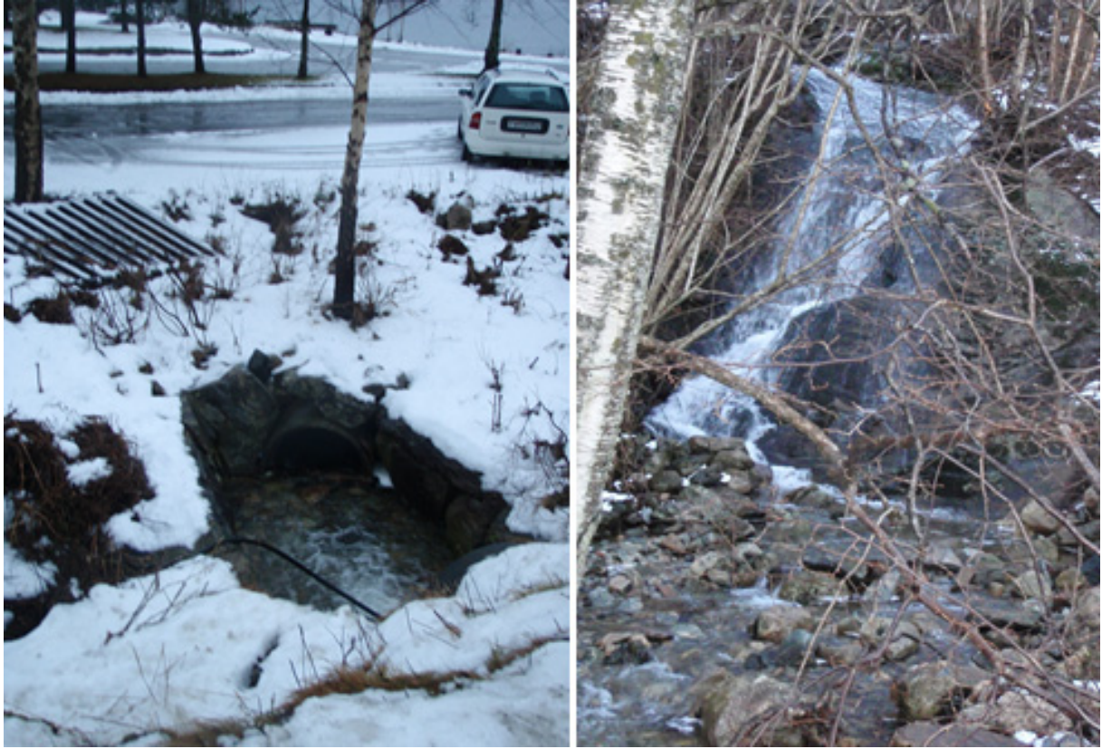
Figur 15. Dagens produktive strekning er lagt i bakken (t.v.), og opprinnelig anadrom strekning ender i foss oppstrøms veien (t.h.).
