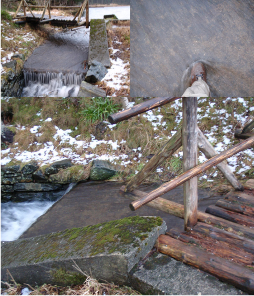
Figur 44. Betongkonstruksjon i utløpet fra Litlevatn.
