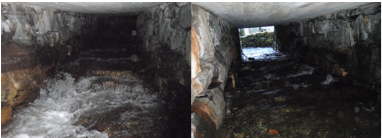
Figur 26. Under veien i kulvert under vei 55.
