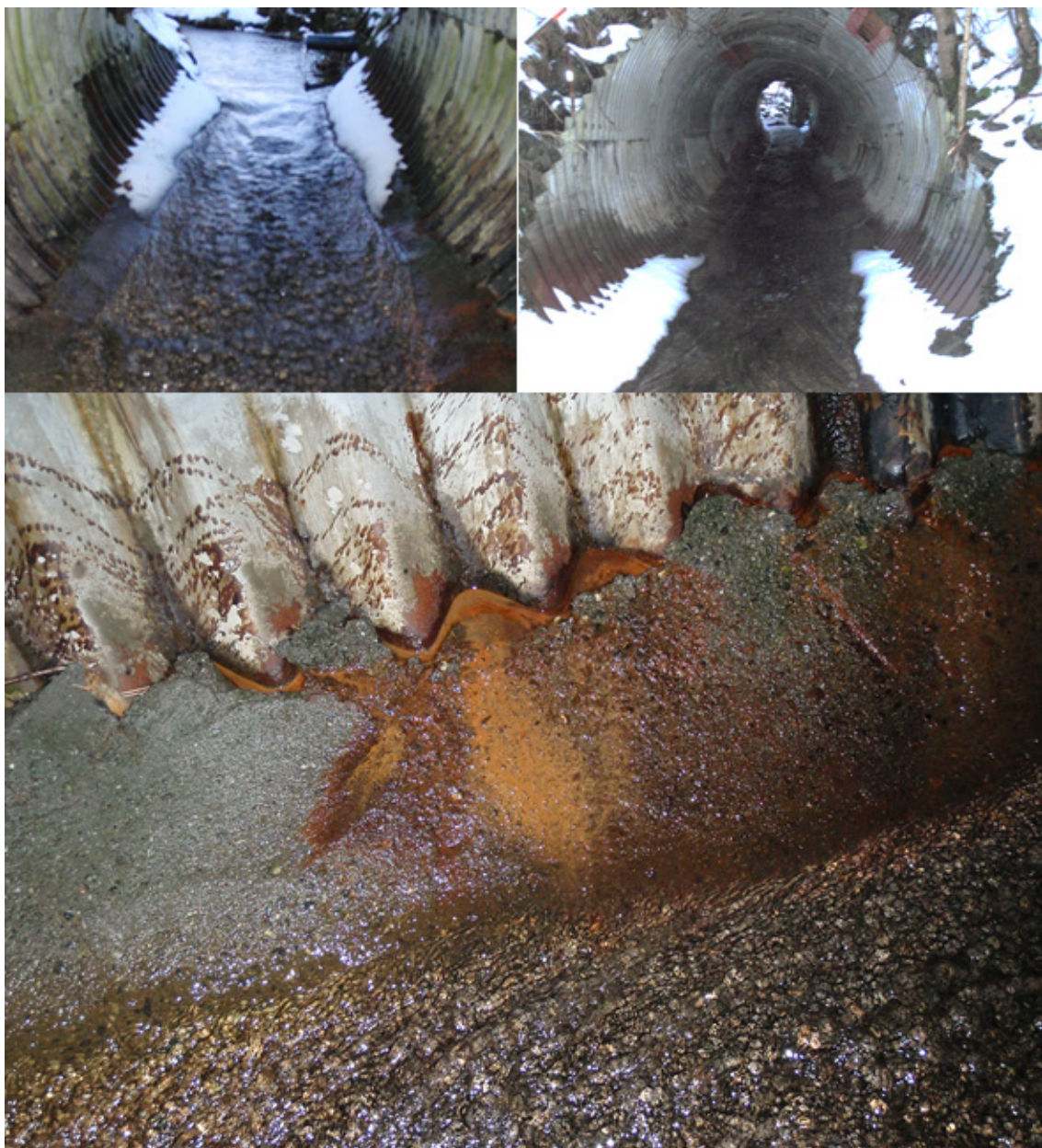
Figur 55. Betongbelagt blikk-kulvert.
