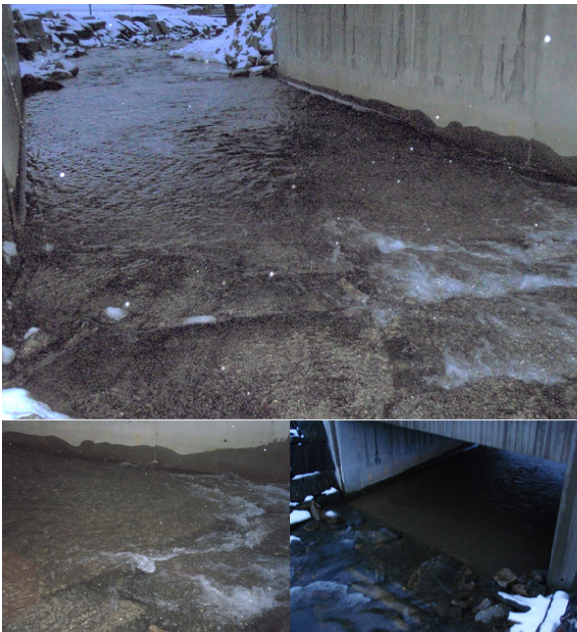
Figur 59. Prestelva med betongkulvert
