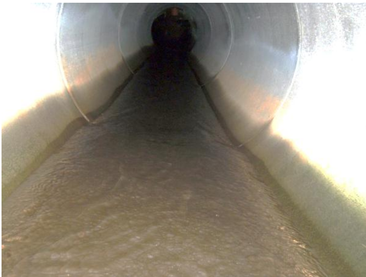
Figur 58. Innside av kulvert
