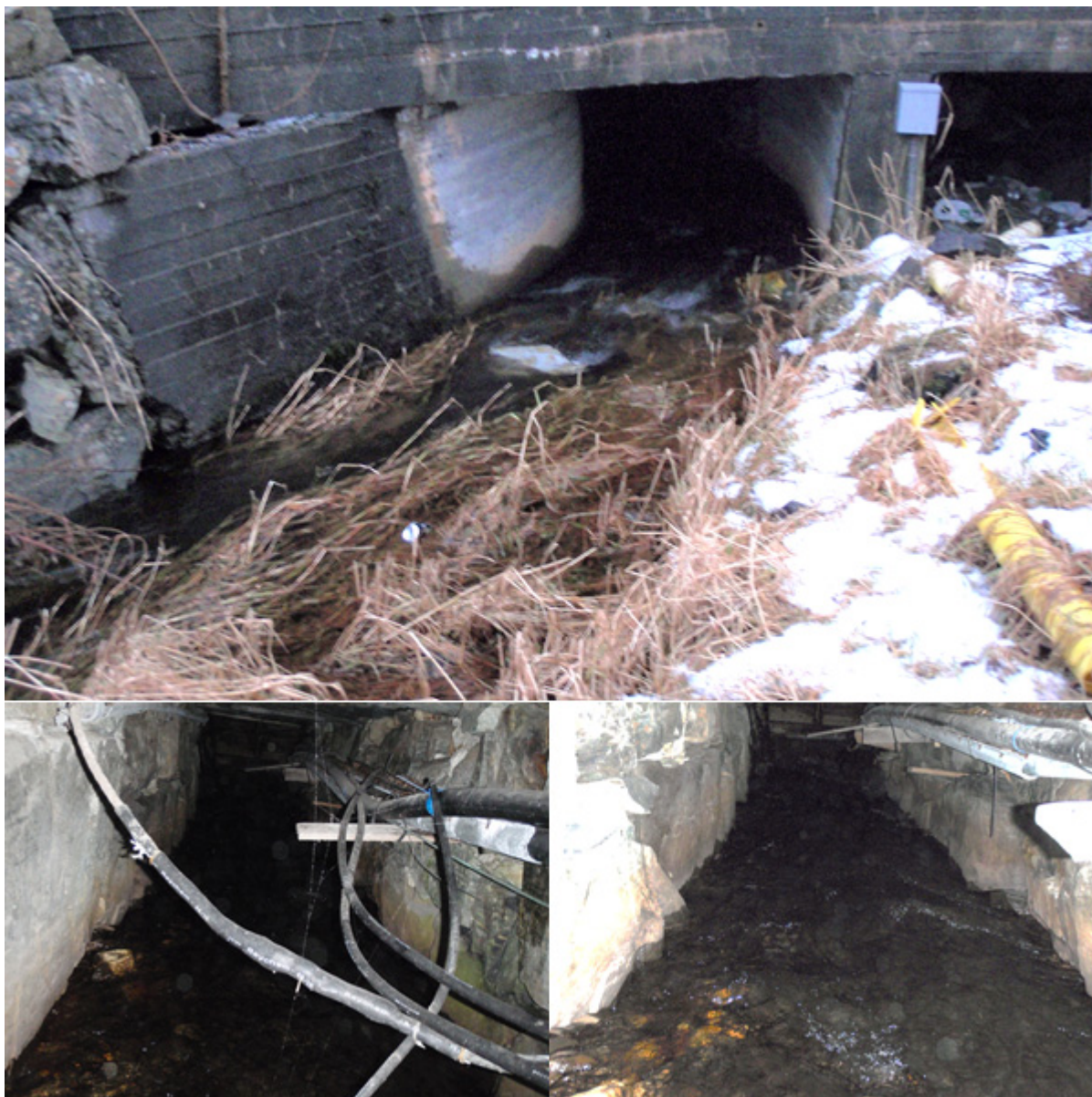
Figur 39. Inngang (øverst) og innside av kulvert (nederst) under 548.
