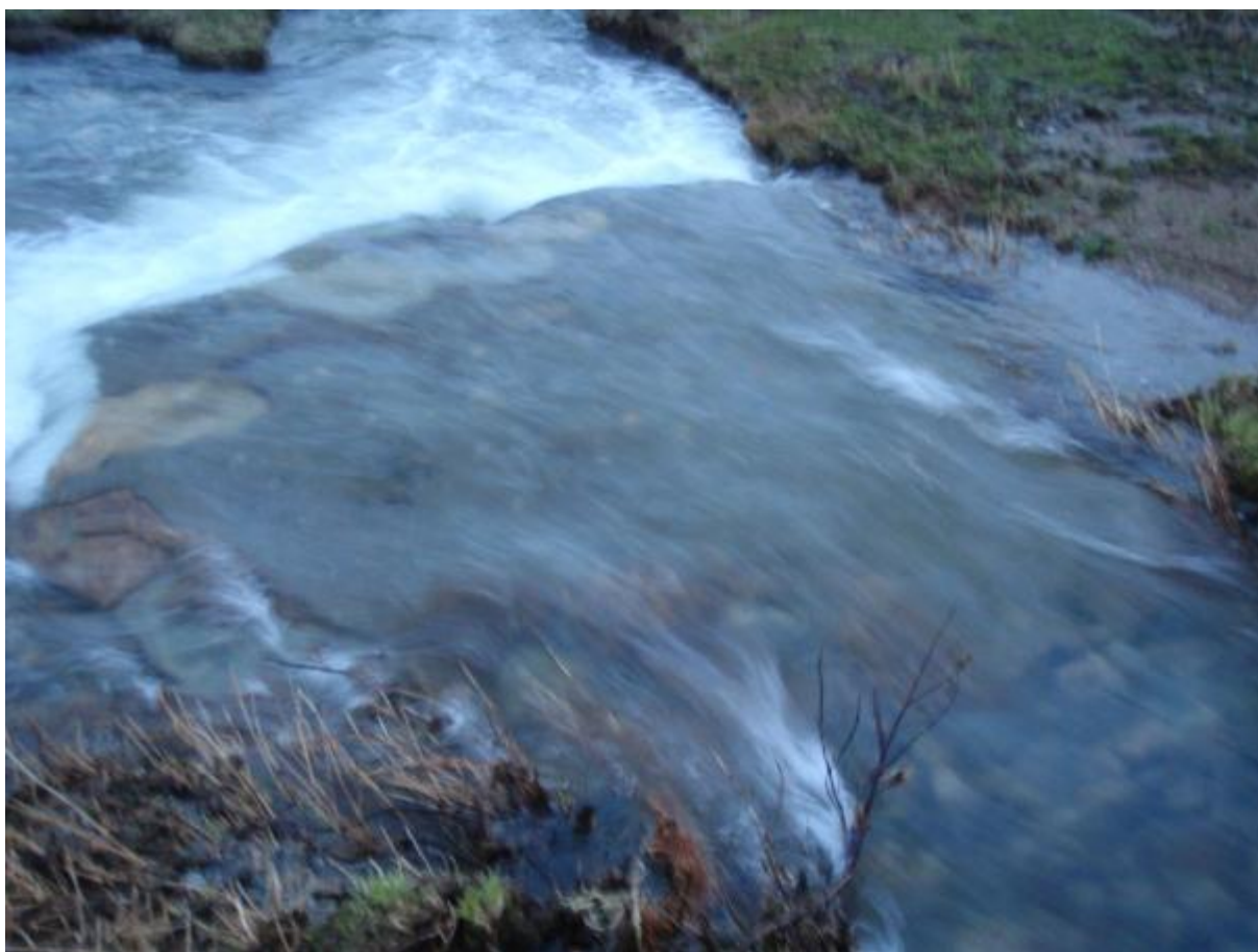
Figur 8. Betongbelagt bunn ved krysningen i flomløpet under E39.
