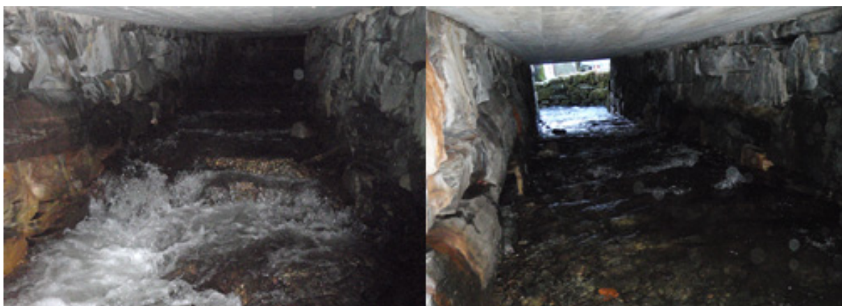
Figur 26. Under veien i kulvert under vei 55.
