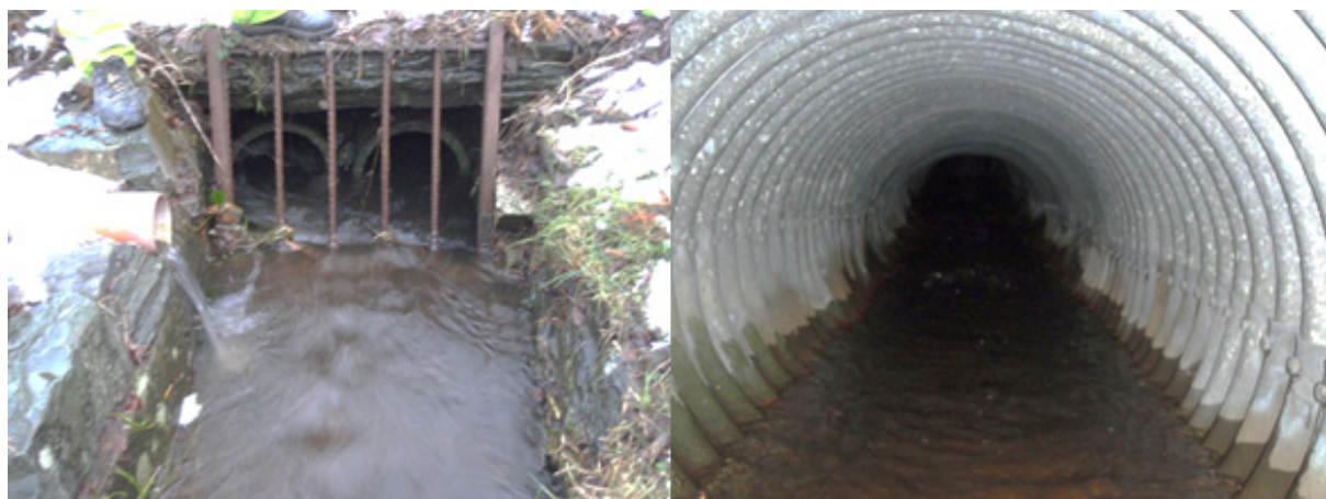
Figur 43. Kulvert under 545 i bekken mellom Litlevatn og Storevatn
