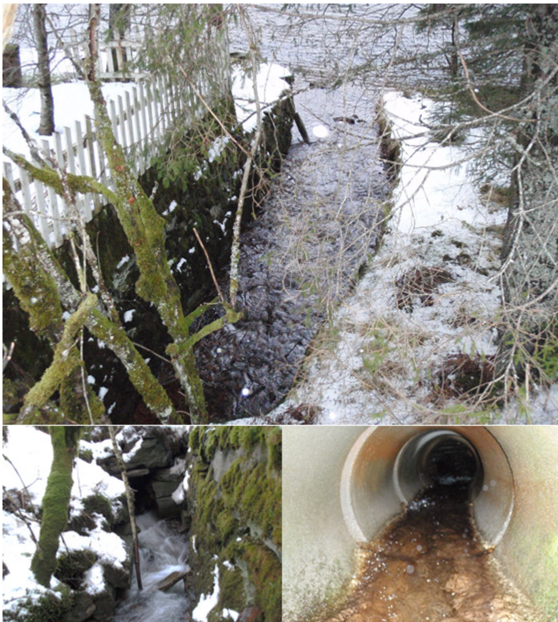
Figur 23. Dagens beskjedne strekning (øverst) i tilknytning til Gaula, og kulvert under 610 og jordbrukslandskap (under).
