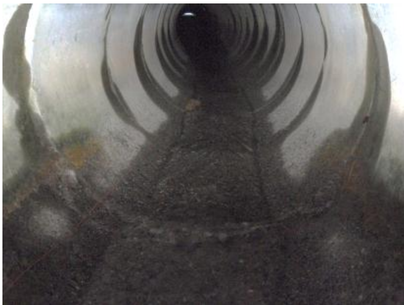
Figur 10. Innside av kulvert i bekken Vassgrovi.
