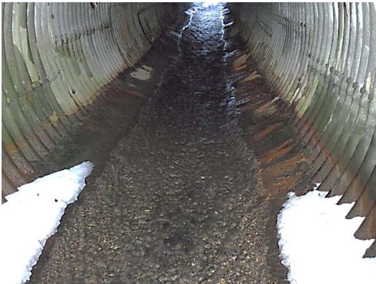
Figur 56. Betongbelagt blikk-kulvert under 39.
