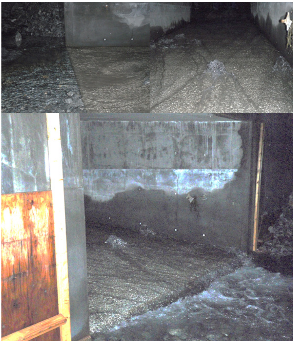
Figur 20. Nyanlagt kryssning under E 39 i Vollelva ved lavvann.
