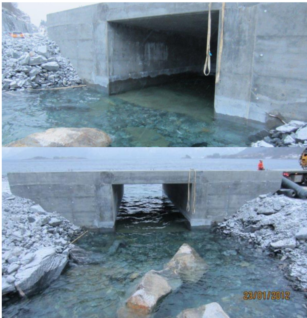
Figur 21. Nyanlagt krysning under E 39 i Vollelva ved flo (foto SVV).
