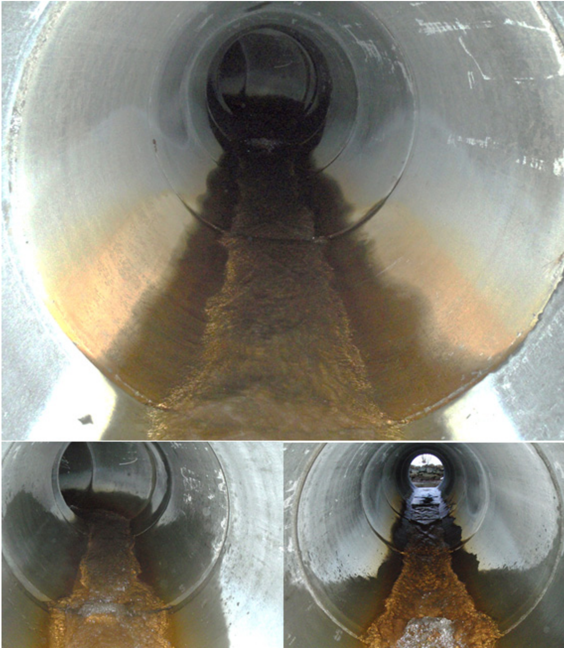
Figur 61. Innside av øvre del av kulvert under 15.
