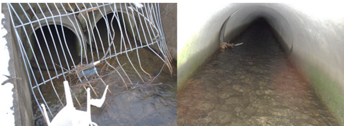
Figur 48. Innløp til kulvert som går under 542.
