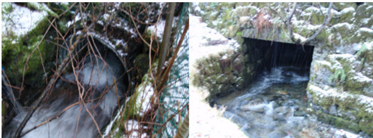
Figur 25. Innløp (venstre) og utløp (høyre) av kulvert under vei 55.
