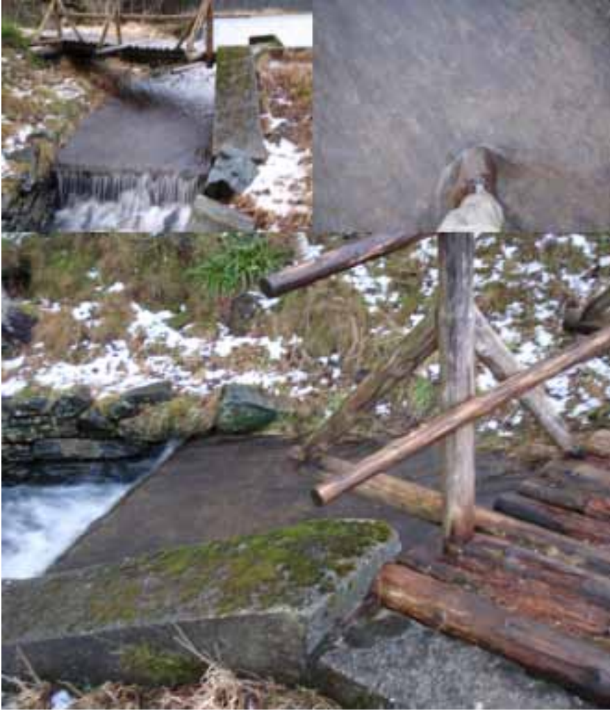
Figur 44. Betongkonstruksjon i utløpet fra Litlevatn.
