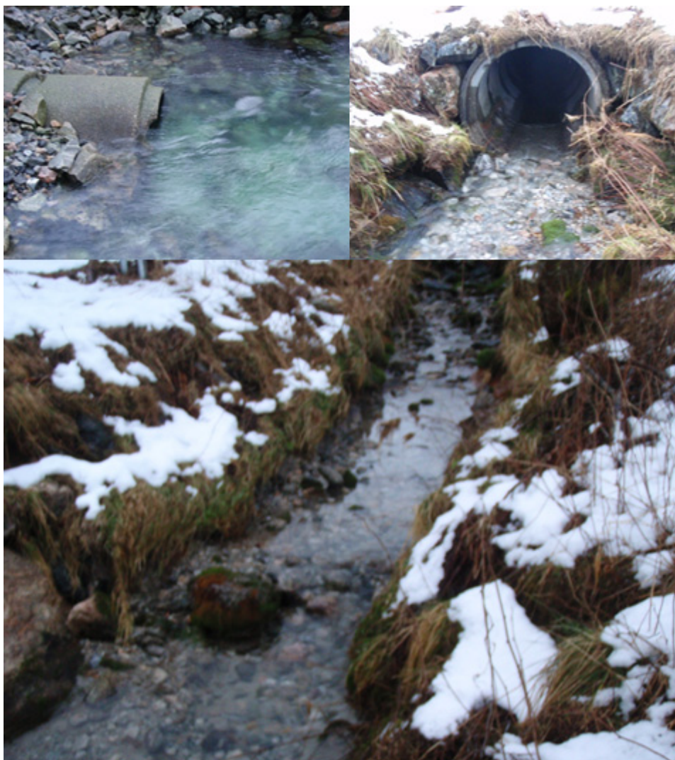
Figur 9. Utløp (øverst t.v.) og innløp (t.h.) i bekken Vassgrovi (nederst)
