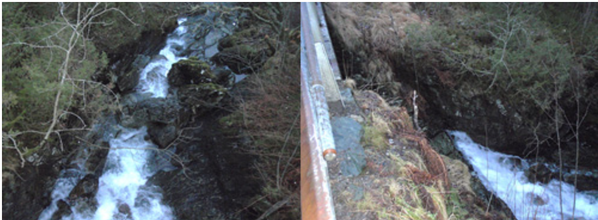
Figur 36. Bratt bekkeløp før kryssninger under 609.
