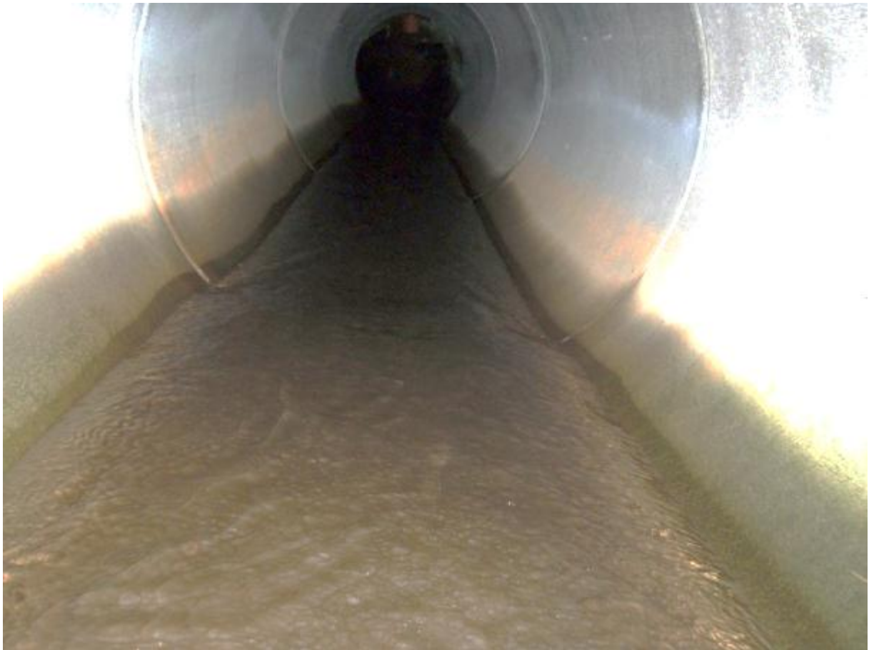
Figur 58. Innside av kulvert
