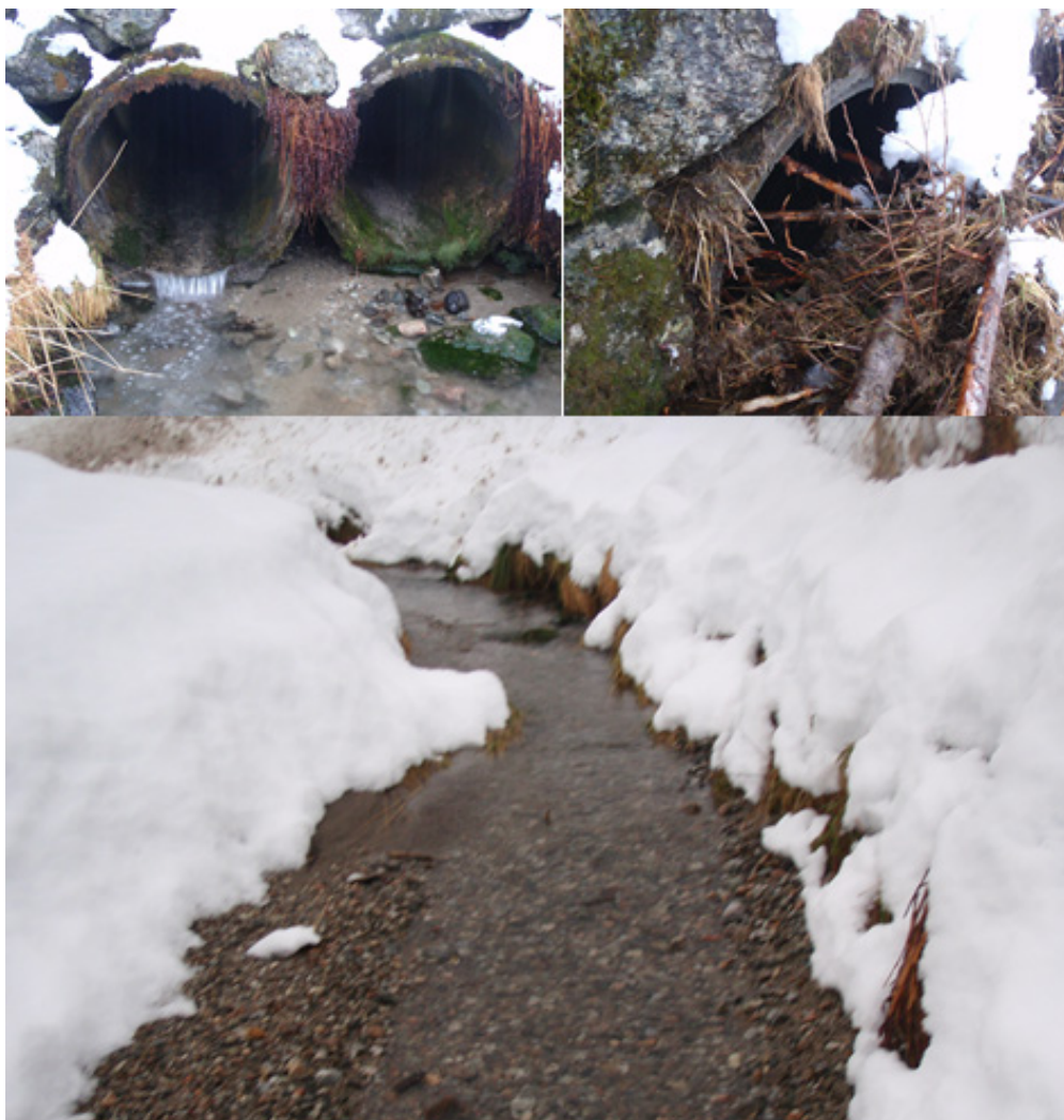
Figur 16. Kulvert (øverst) under hovedveien i Kaldebekken i Esefjorden (under).
