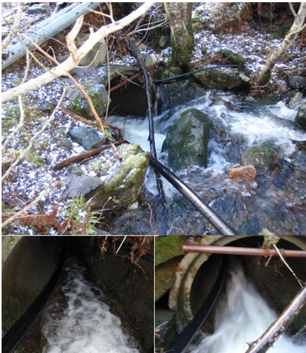
Figur 34. Inngang til kulvert under 65.
