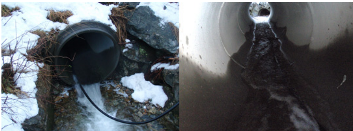
Figur 14. Kulverten under veien.
