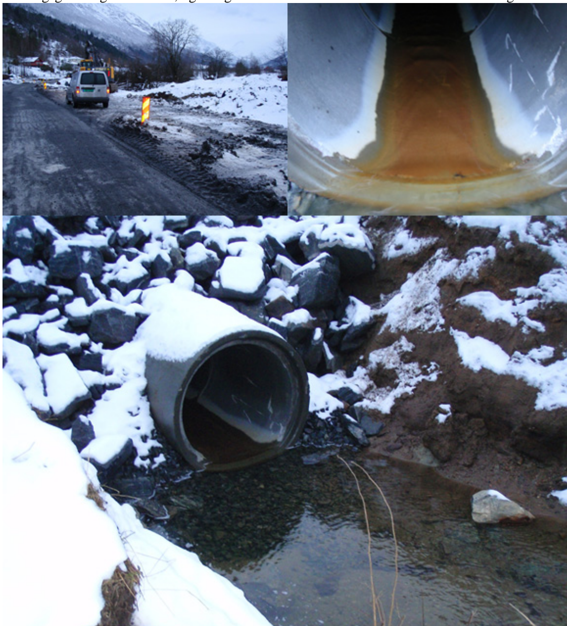
Figur 60. Inngang til kulvert under 15 i sidebekk til Stryneelva.
