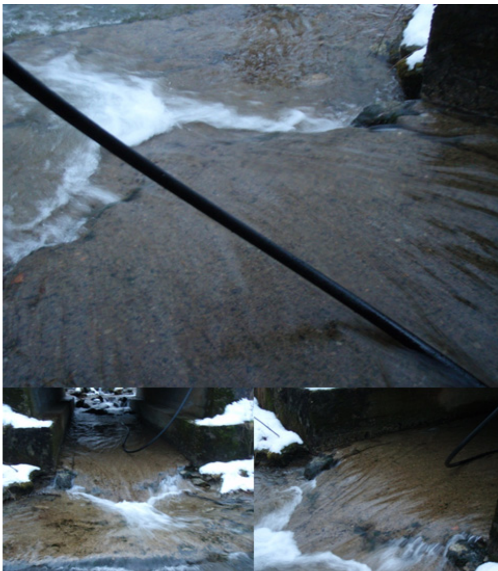
Figur 12. Betongbelagt bunn i kulvert
