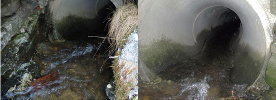
Figur 29. Innløp til kulvert under boligområde.
