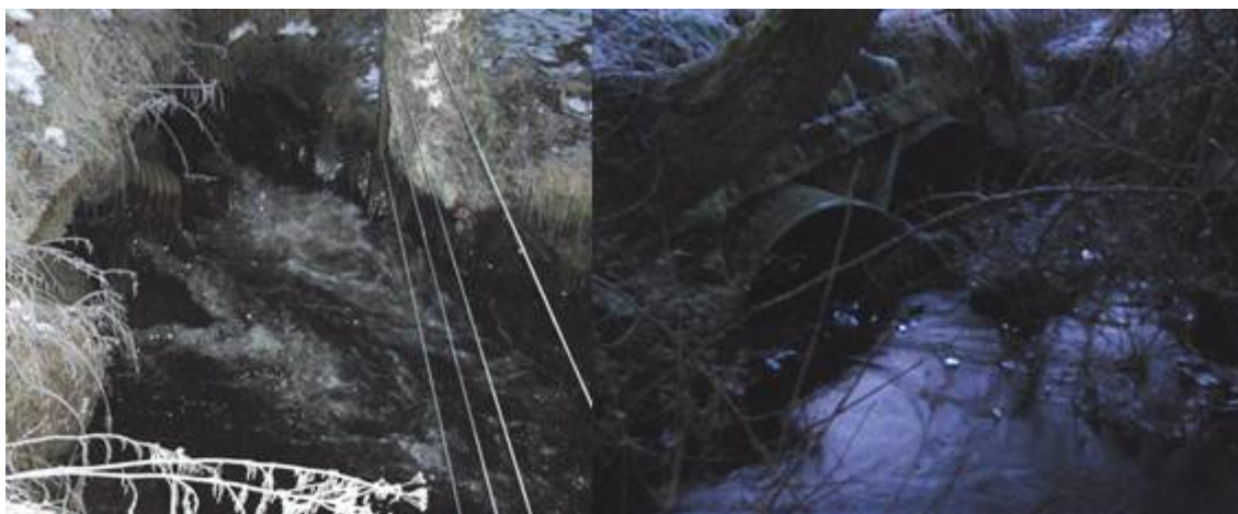
Figur 111. Kulvert under grusvei ved Smemo (14). Foto: NIVA
