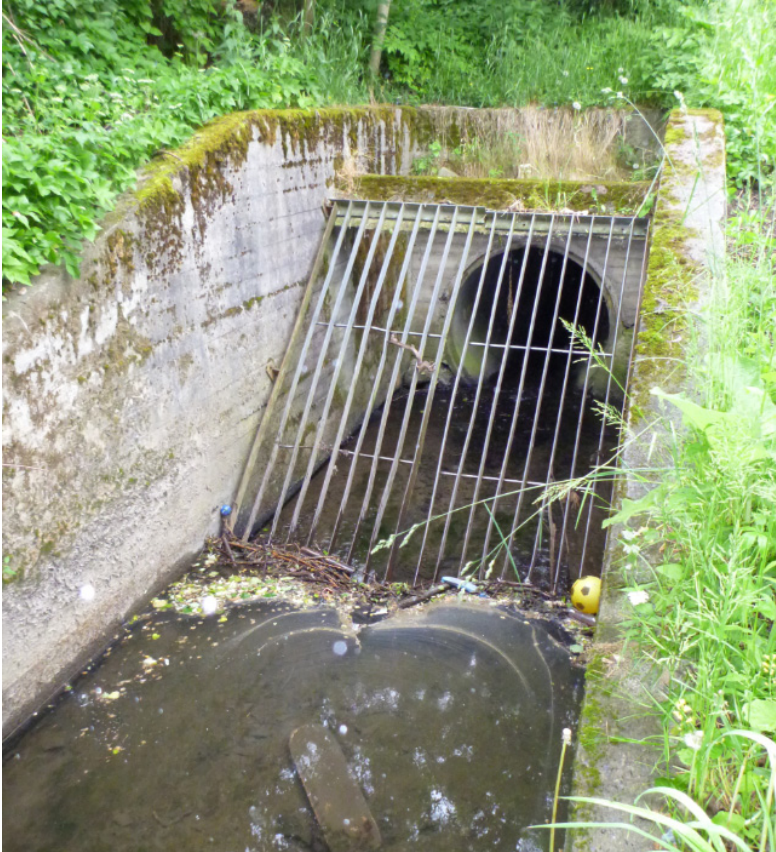
Figur 66. Kulvert under Refstadveien (1), der bekken går i en lengre lukking nedstrøms. Foto. NIVA
