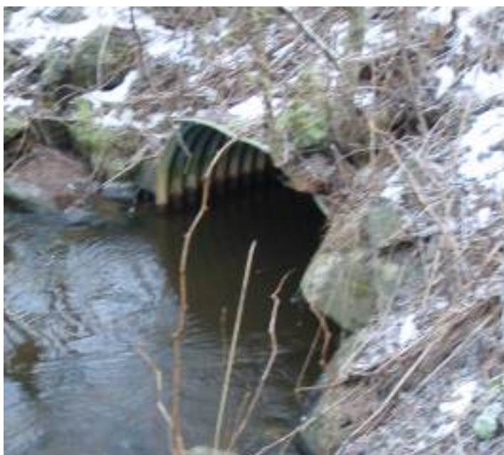
Figur 118. Kulvert under vei langs bekken (5). Foto: NIVA
