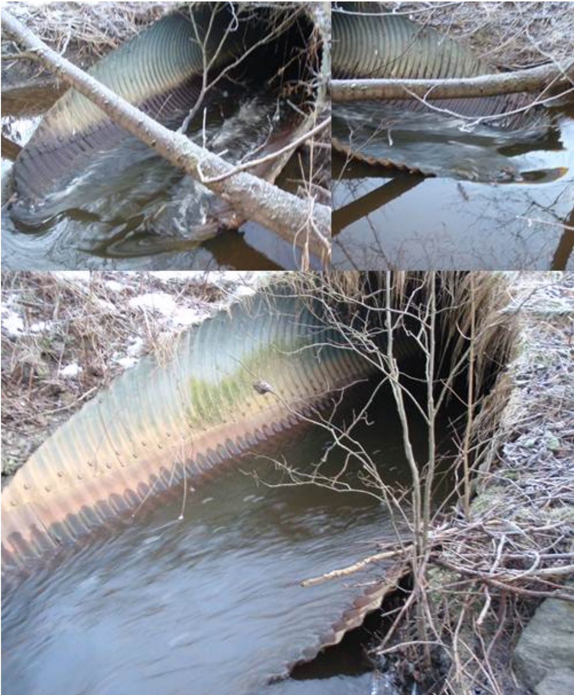
Figur 116. Kulvert under Bjørnerudveien (3). Foto: NIVA
