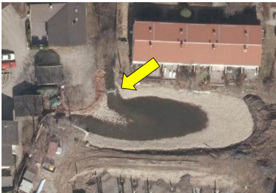
Figur 11. Flyfoto av steinsterskel (2) i åpen strekning mellom E18 og Jernbaneområdet. Foto hentet fra www.finn.no/kart .
