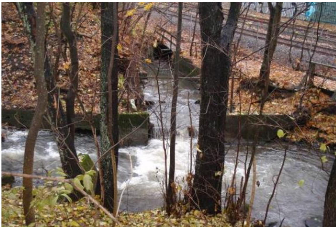
Figur 52. Gaustadbekken møter hovedelva, med kulvert under T-banen (4) og en liten terskel før samløp (3). Foto: NIVA
