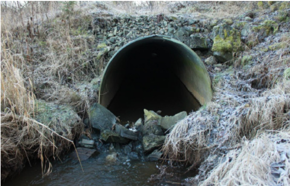
Figur 132. Kulvert under lukket strekning og traktorvei (7). Foto: Bymiljøetaten
