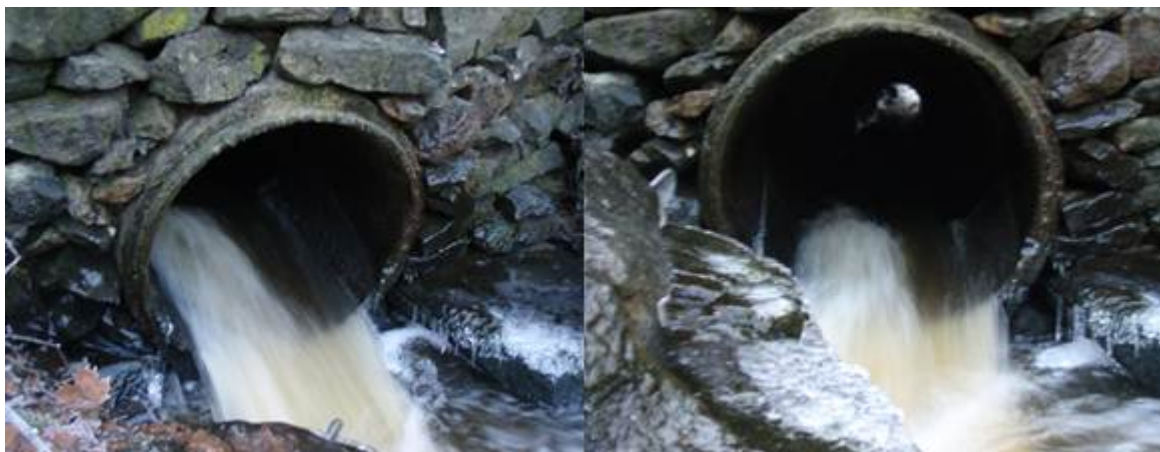
Figur 119. Utløp av kulvert (6). Foto: NIVA
