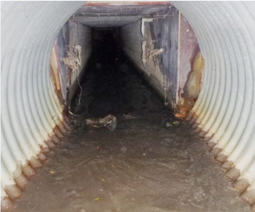
Figur 14. Overgang fra blikk-kulvert til betongkulvert under jernbaneområdet (3). Foto: NIVA.
