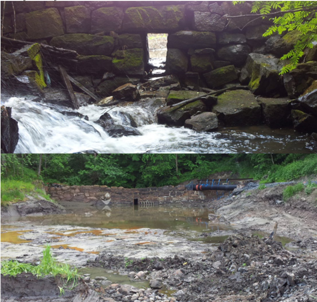
Figur 88. Demningsområdet og nedtappet dam (26). Foto: NIVA
