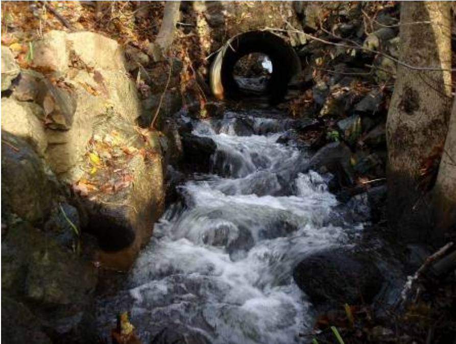
Figur 72. Kulvert (7) oppstrøms stasjonsområde HOV1 i Hovinbekken. Foto: NIVA
