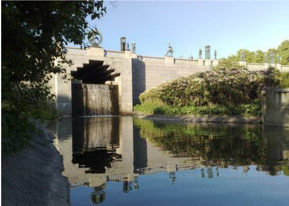
Figur 49. Det er åpenbare brudd på kontinuitet mellom øvre og nedre dam for vandrende fisk i Frognerdammene (2). Foto: NIVA
