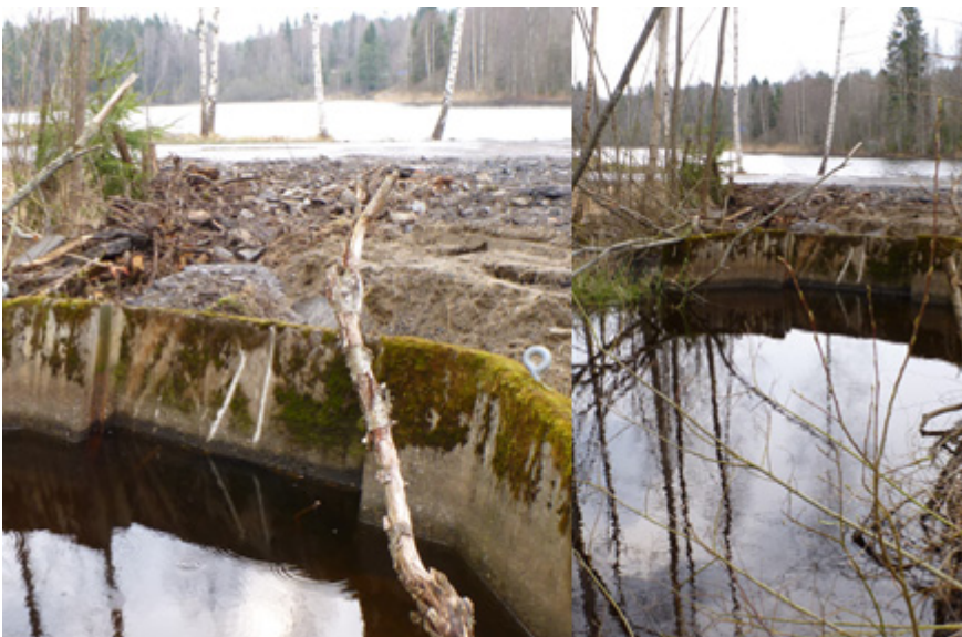
Figur 129. Utløp av kulvert er under vann og vises ikke fra overflaten. Foto: NIVA
