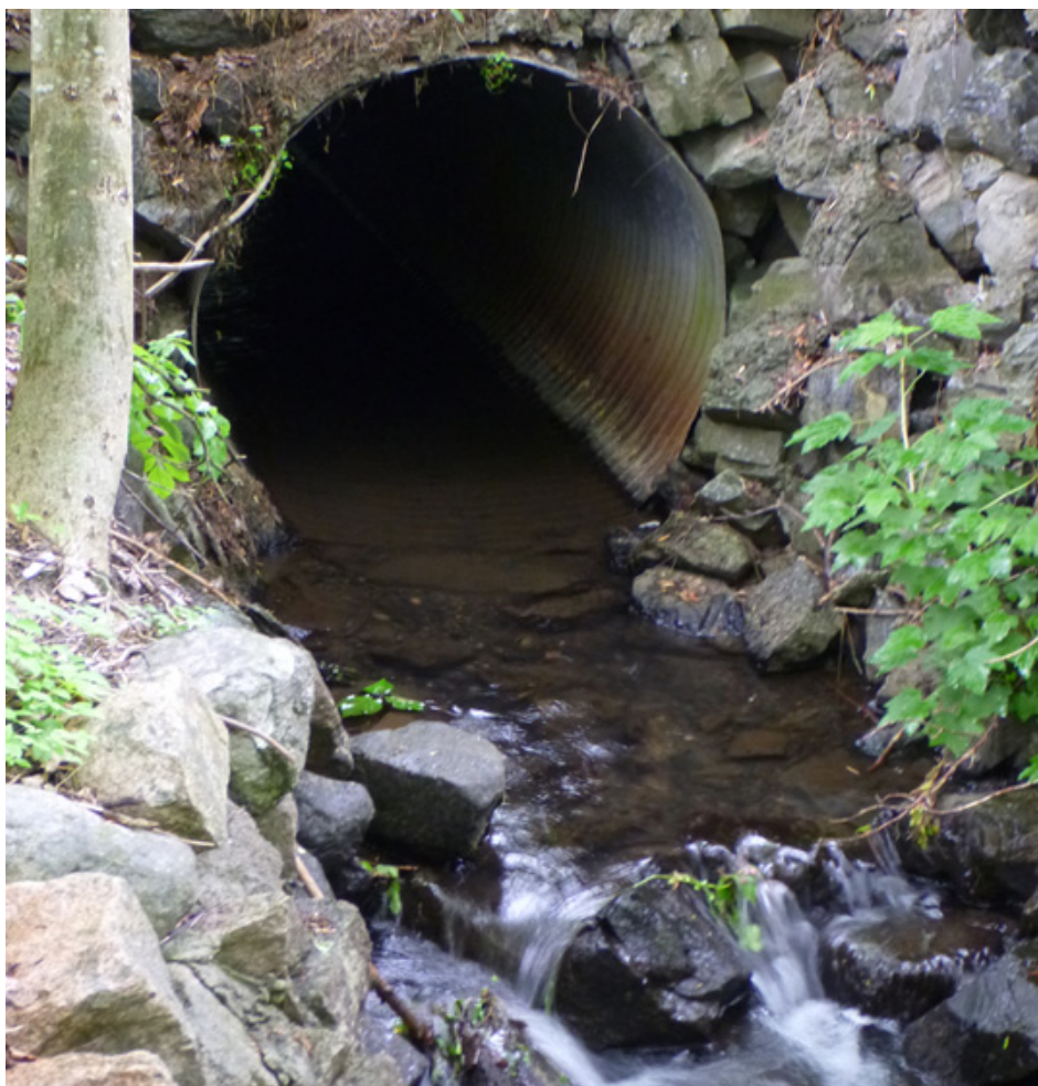
Figur 71. Kulvert under Brobekkveien (6). Foto: NIVA
