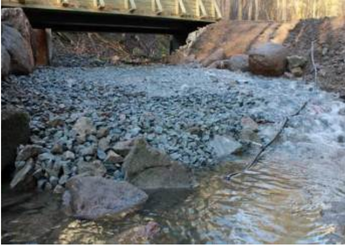
Figur 18. Utlagt pukk i bekkesenga (2). Foto: Bymiljøetaten.
