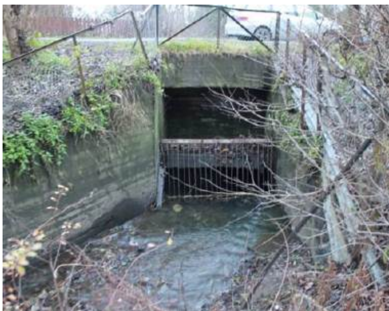
Figur 16. Kulvert ved inngang under Sigurd Iversens vei (5). Foto: Bymiljøetaten.
