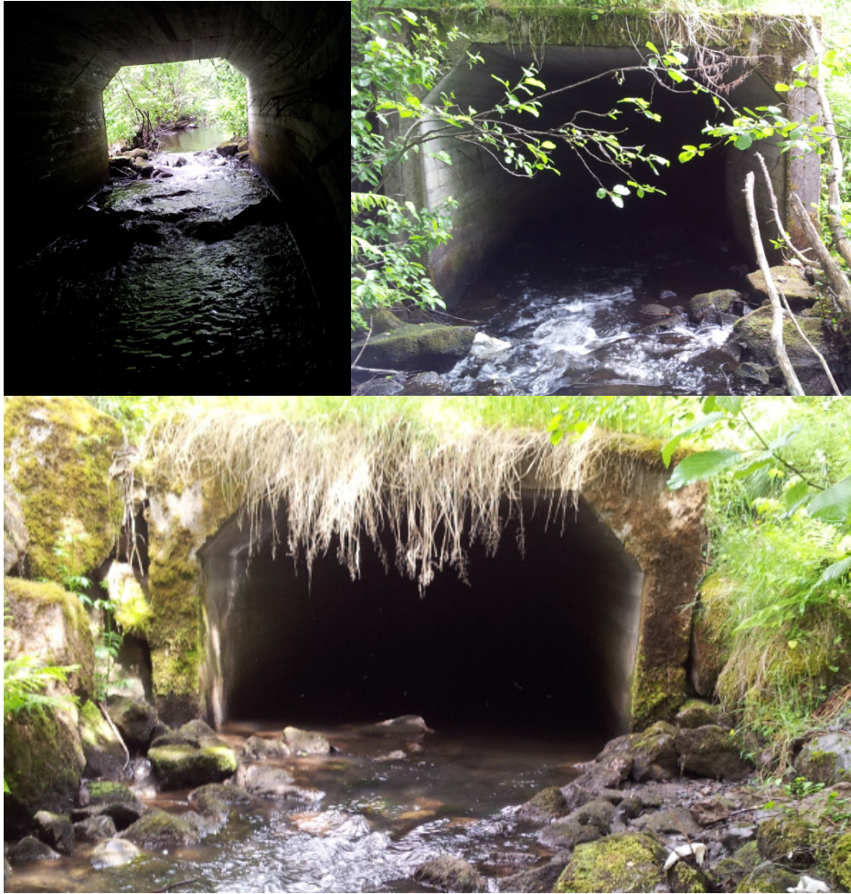
Figur 91. Kulvert (innside øverst til venstre, innløp øverst til høyre og utløp under) i forbindelse med krysning under T-banelinja ved Grorud (29). Foto: NIVA
