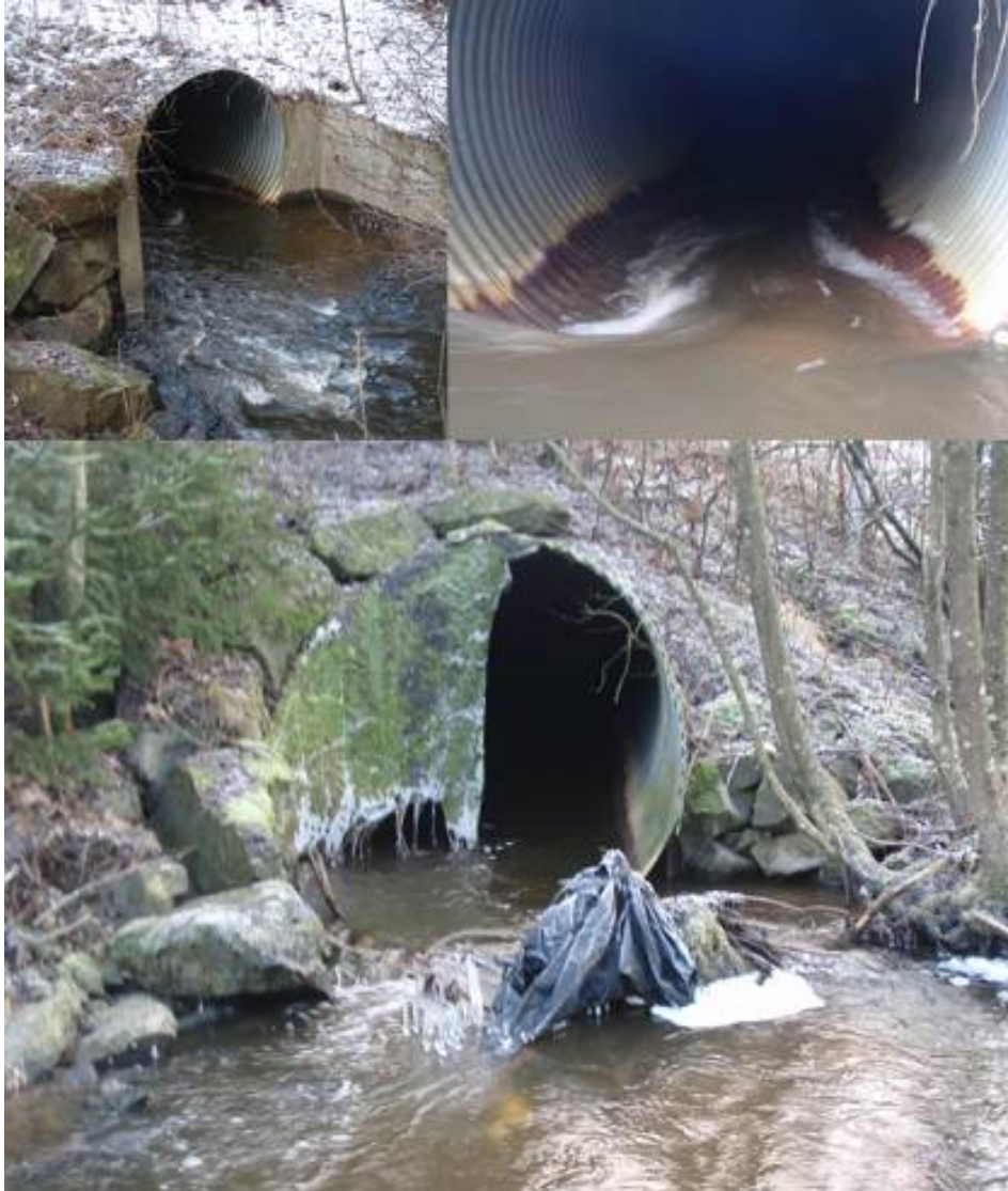
Figur 114. Kulvert under krysset Ljansbruveien/Mortensrudveien (1). Foto: NIVA
