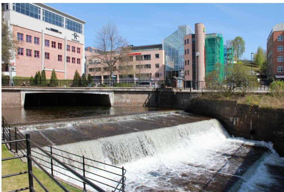
Figur 62. Terskel mellom AKR3 og AKR2 (15)(Foto: Bymiljøetaten).
