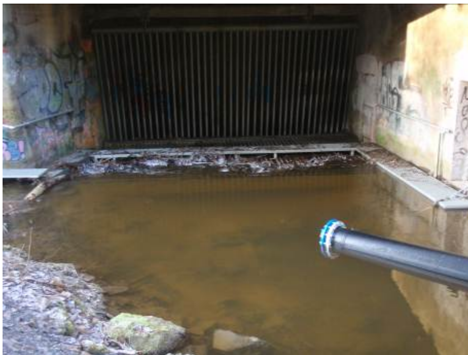
Figur 99. Sperring med liggende og hengende rist i begge løp gjør utvandringmuligheter vanskeligere for større gytefisk på de fleste vannføringer (3). Foto: NIVA
