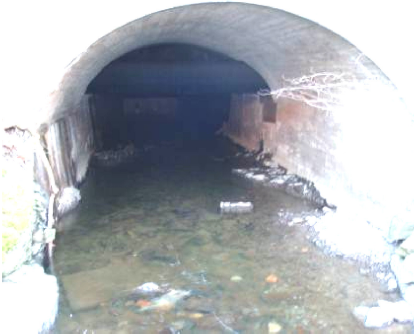
Figur 27. Kulvertinnløp Engebregts vei (2). Foto: NIVA
