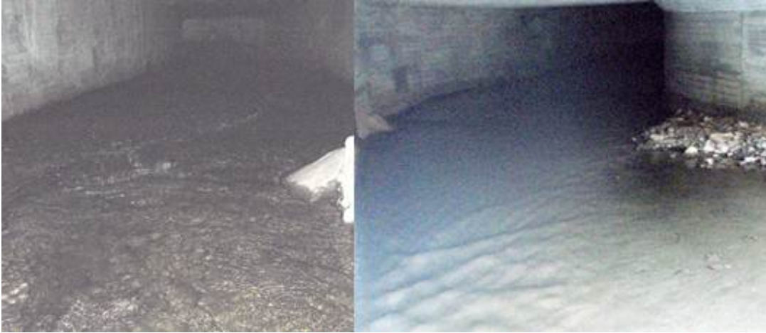
Figur 28. Innside av kulvert Engebregts vei, med flat betongbunn og noe vannhastighet over en lengre strekning (2). Foto: NIVA
