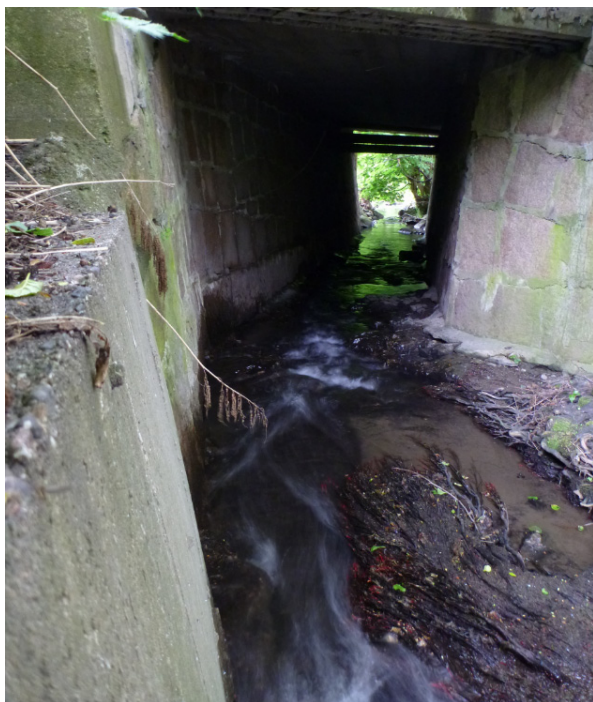
Figur 70. Kulvert under Økernveien (4). Foto: NIVA
