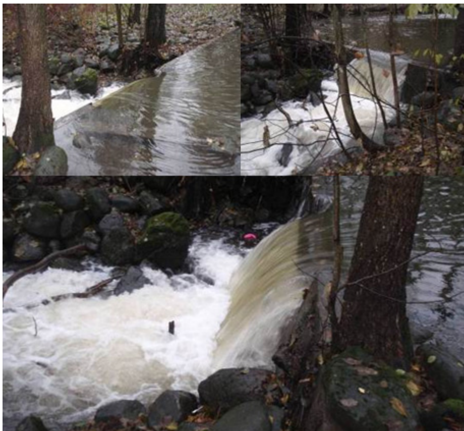
Figur 47. Ukurant terskel (2) i Frognerelva, med høyt sprang og vanskelige oppgangsmuligheter for gytefisk. Foto: NIVA.
