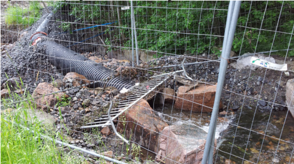
Figur 89. Tømmeåpning. Foto nedstrøms demning. Foto: NIVA
