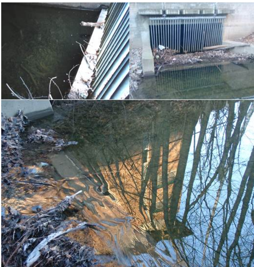
Figur 26. Kulvertinngang Hofferveien (1). Foto: NIVA
