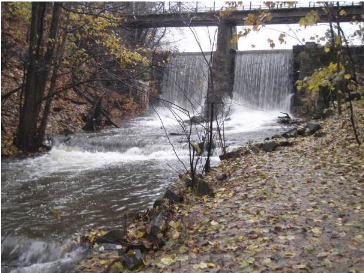
Figur 45. Demning nedre dam, som i dag er et permanent vandringshinder for anadrom laksefisk og sannsynligvis også for ål (3). Foto: NIVA
