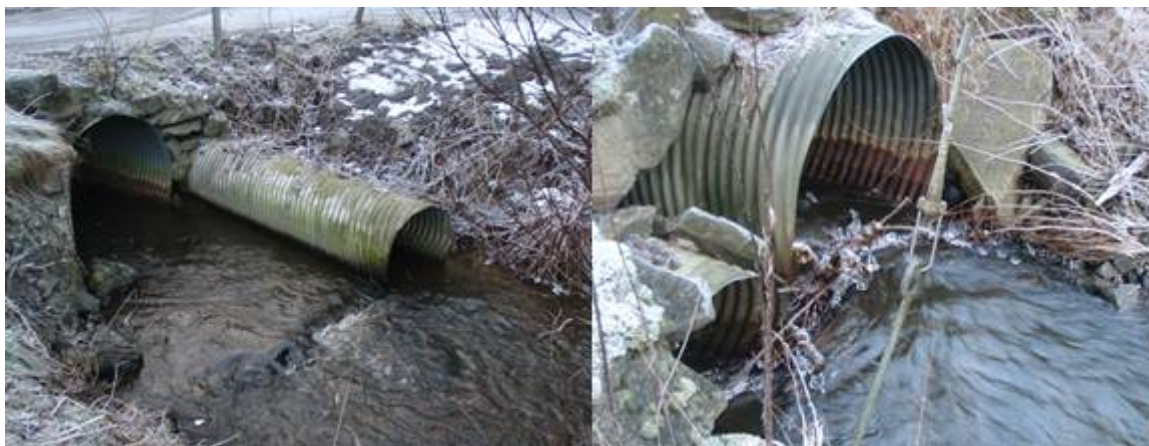
Figur 117. Kulvert under grusvei (4). Foto: NIVA
