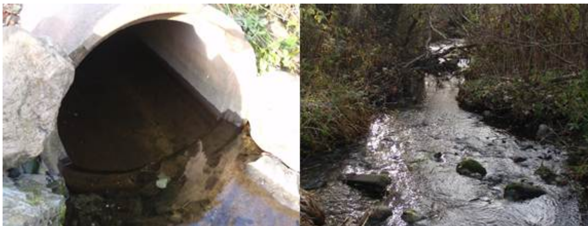
Figur 21. Øvre, urørte strekninger av Mærradalsbekken (t.h.) og kulvert under gangbru (t.v.)(3). Foto: NIVA
