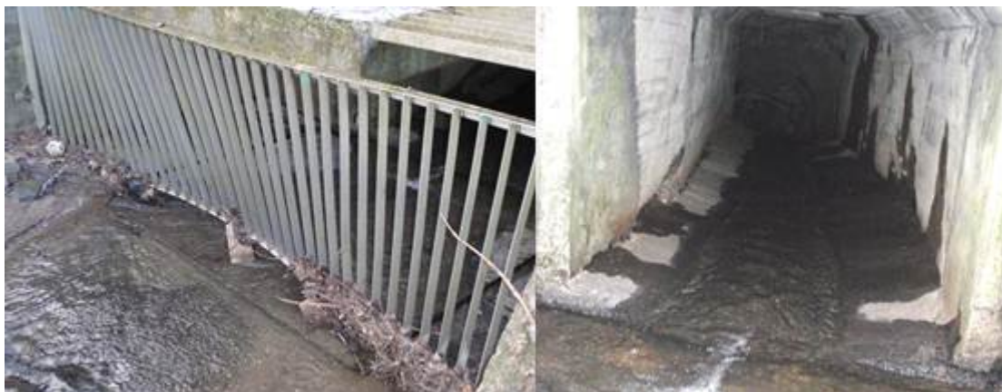
Figur 104. Kulvert i nedre del av Prinsdalsbekken før munning til Ljanselva (2). Foto: NIVA
