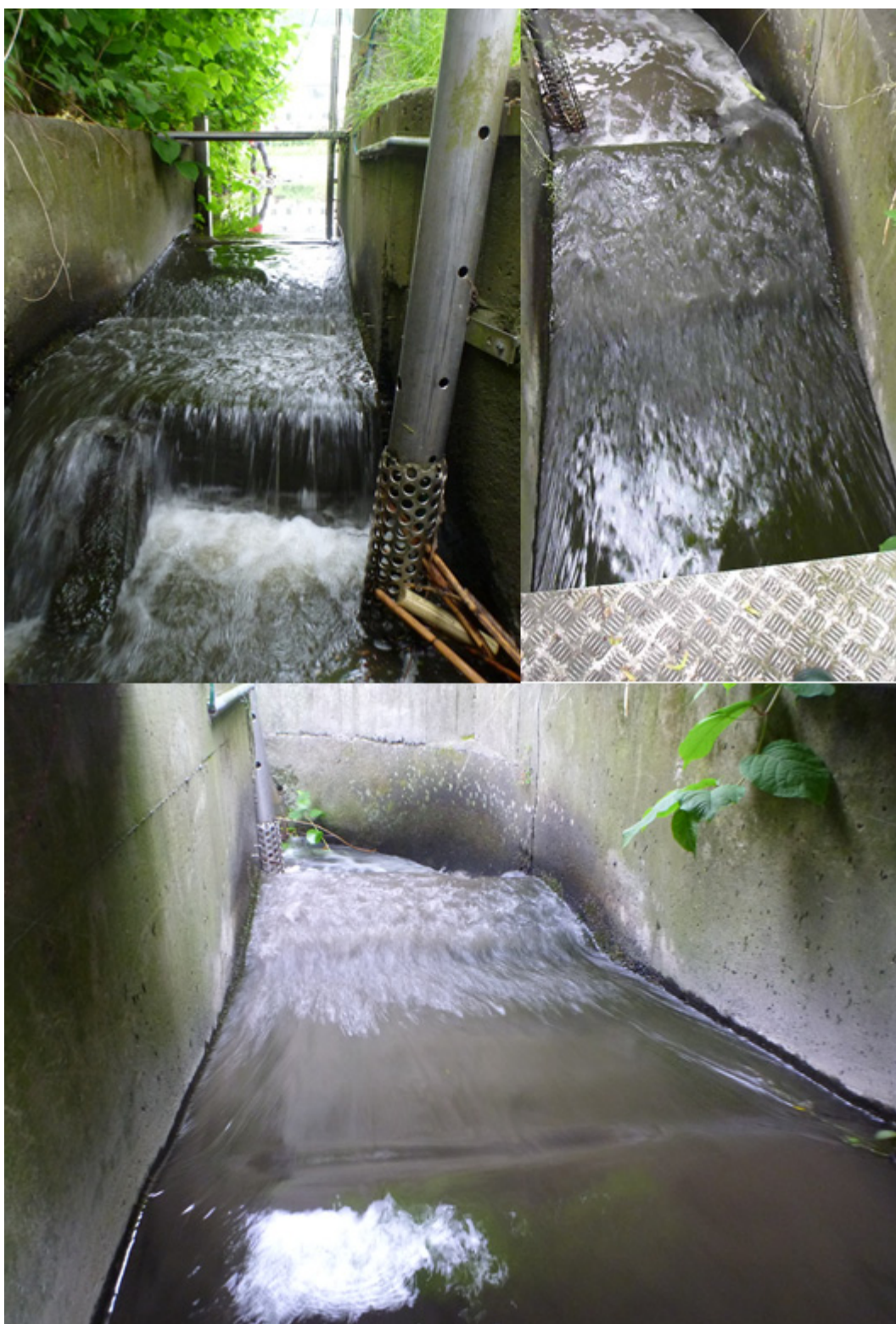
Figur 7. Inngang til lukking under E18 (1b). Foto. NIVA.
