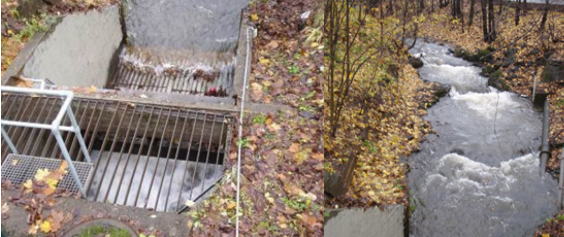
Figur 51. Rist foran innløpet til kulvert under lukket strekning ved F. Nansens vei (t.v.)(1) og bekkestrekninger oppstrøms (t.h.). Foto: NIVA
