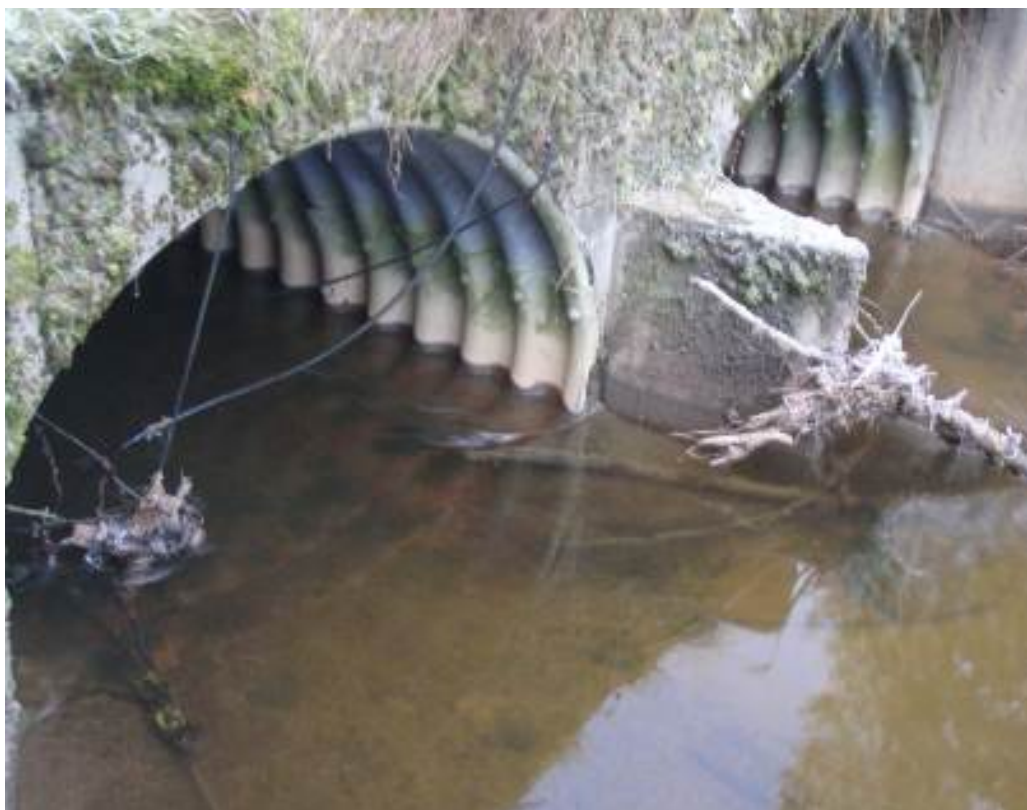
Figur 105. Kulvert Munkerudveien (6). Foto: NIVA
