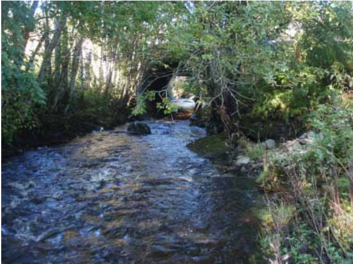
Figur 34. Kulvert under Fv 285 i Tessemelva.
