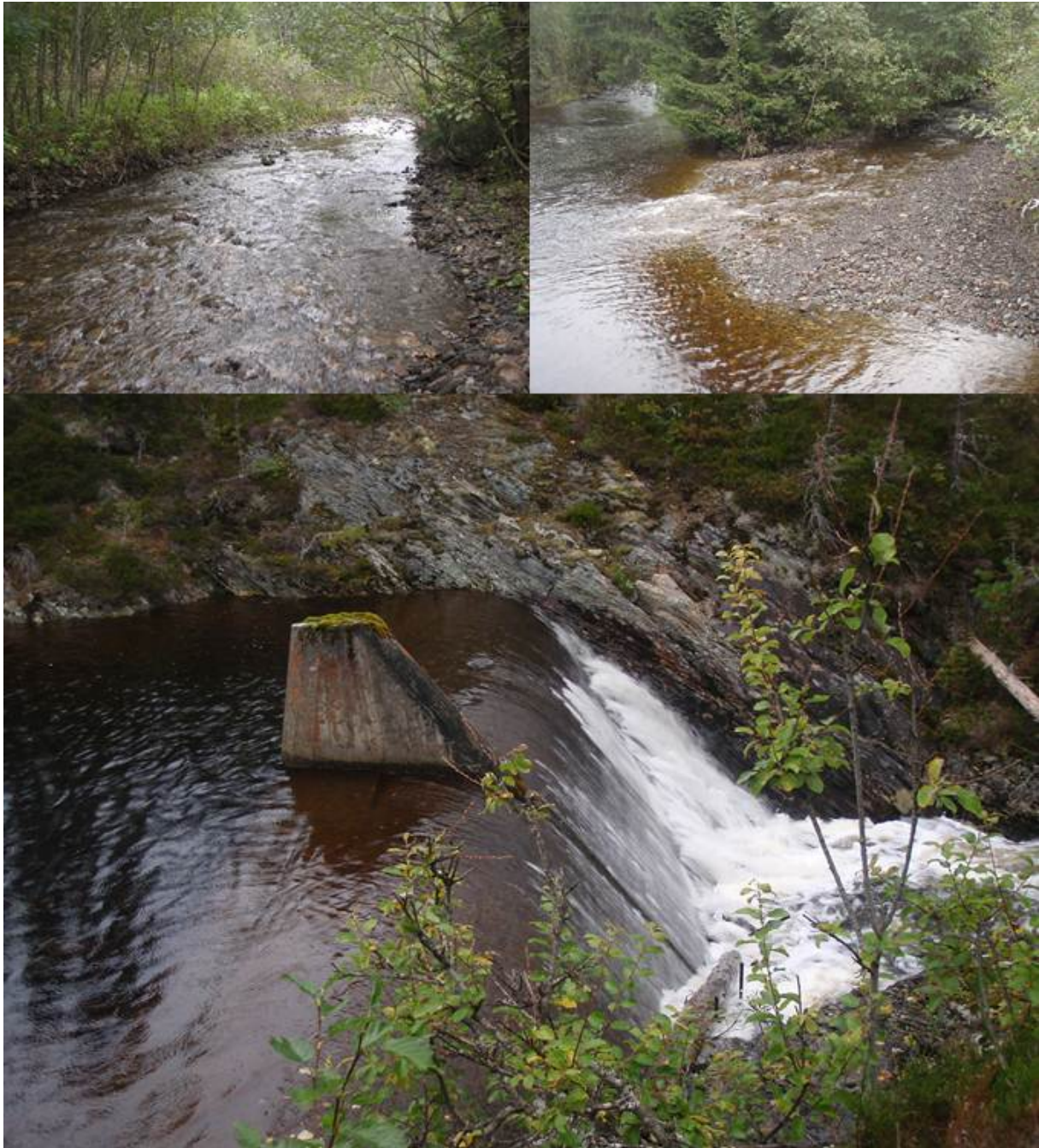
Figur 8. Stasjonsområdet i Lauvåa (øverst til venstre), Lauvåas munning til Leksa (øverst til høyre) og demningen ved utløpet av Lauvatnet (nederst). Foto: Morten Andre Bergan
