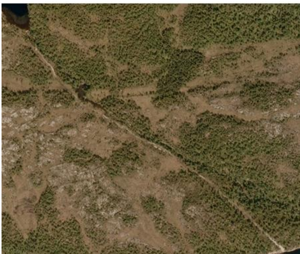
Figur 26. Oversiktsbilde av Tverrelva før (øverst) og etter (nederst) inngrep, der særlig grusveien synliggjøres. (Kilde: www.norgebilder.no )
