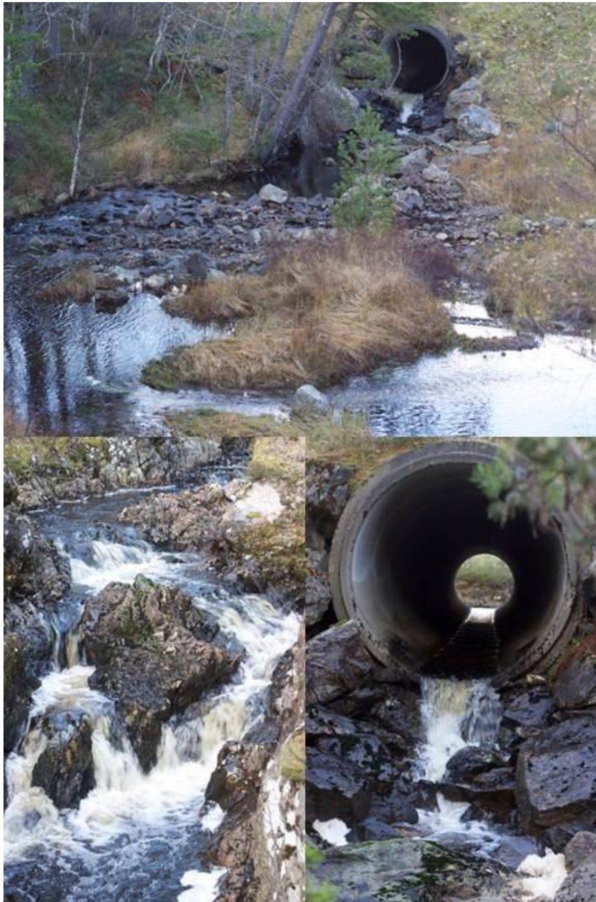
Figur 100. Kulvert under Fv 381 i Merkesåa (øverst og nederst t.h.), og naturlig vanskelige (men trolig passerbare) oppgangsforhold i vassdraget nedstrøms Fv 381. (Foto: privat)
