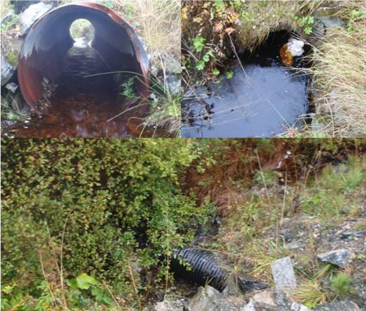
Figur 47. Krysning under privat grusvei (øverst tv.), nedre krysning under Fv 713 (øverst t.h.) og øvre krysning under Fv 713 (nederst) i tilløpsbekken til Litlsandvatnet.
