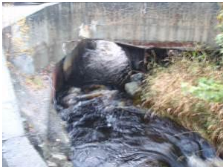
Figur 6. Kulvert under privat vei.
