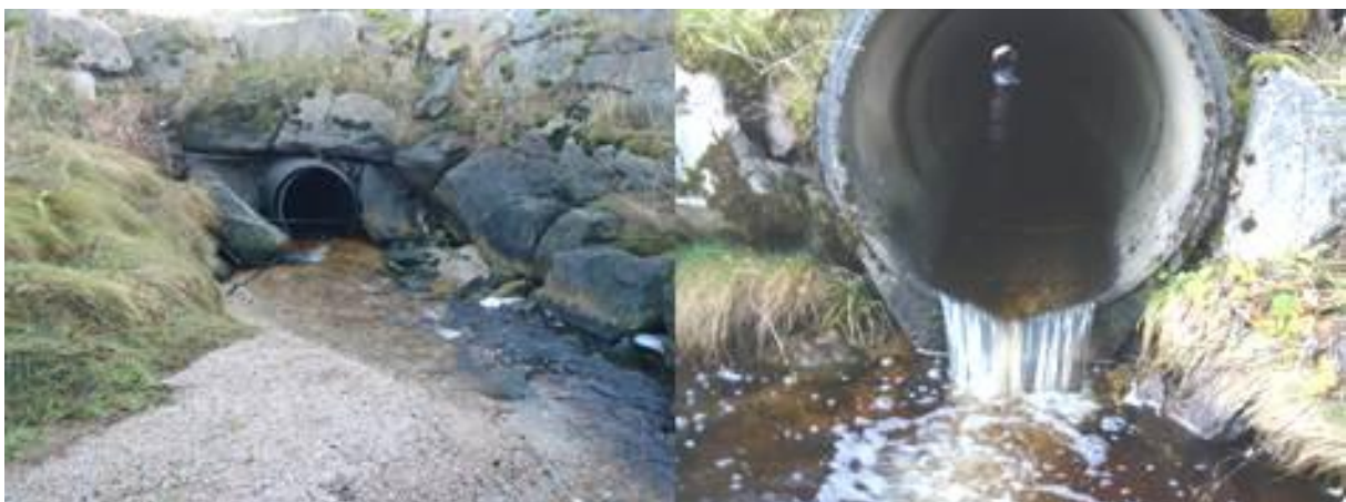
Figur 66. Krysning før munning (t.v.) og under Fv 714 (t.h.).
