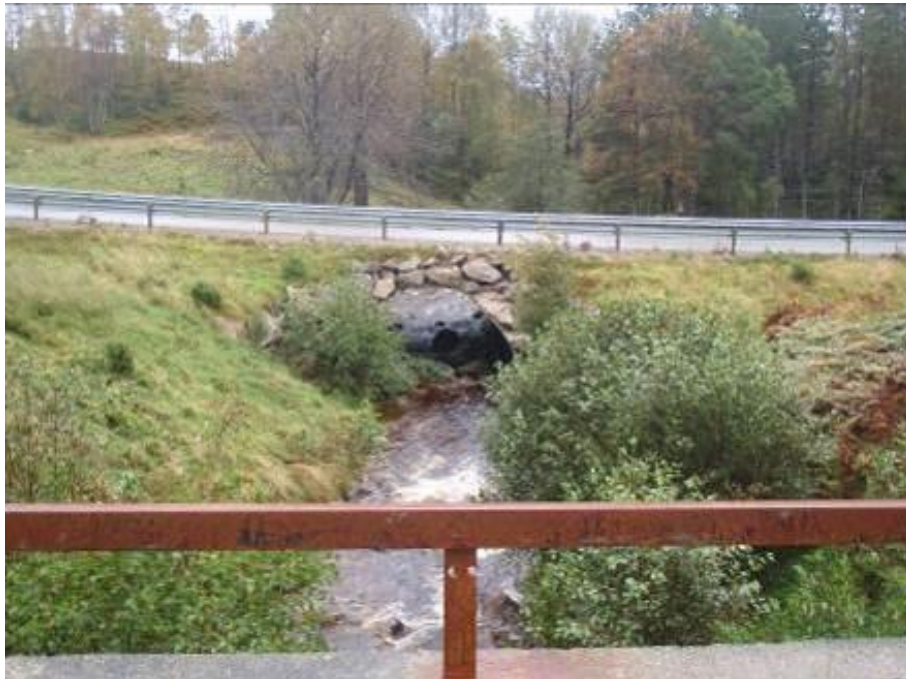
Figur 13. Krysning med bevart bekkebunn under Fv 713.
