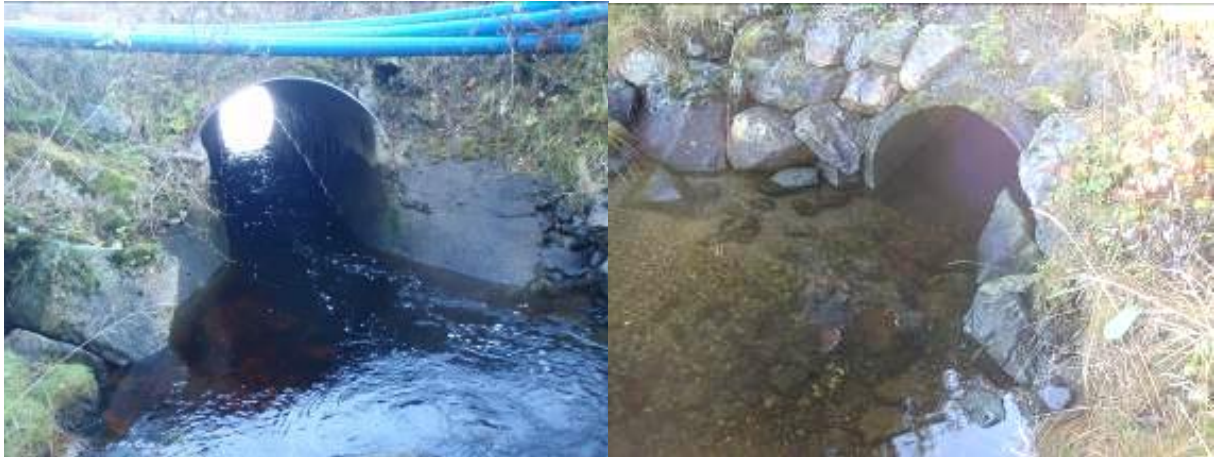
Figur 110. Krysning under Fv 342 i Strandaelva (t.v.) og ved mindre grusvei i Bonbekken (t.h.).
