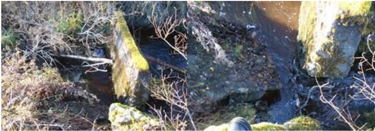
Figur 113. En liten åpning i steindemning gjør at sjøørret i dag kan passere. Denne kan lett tettes dersom Statens vegvesen fortsetter å dumpe trevirke og kvist i bekken.
