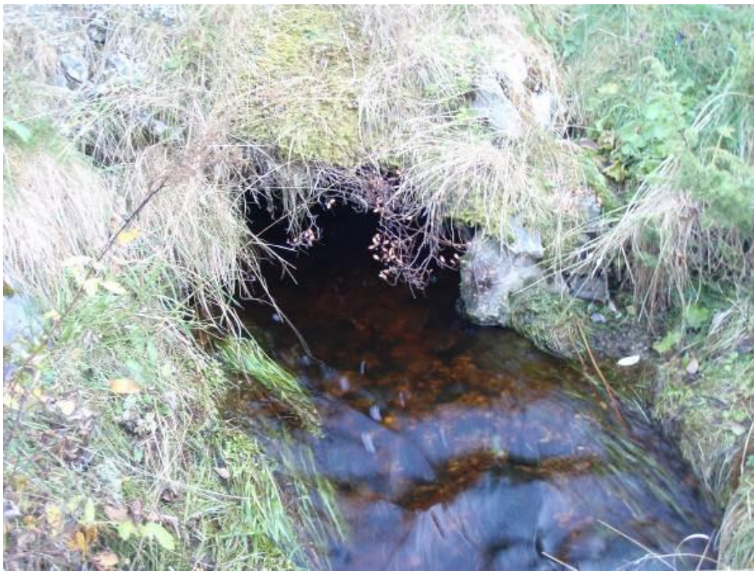
Figur 123. Kulvert under Fv 365 i bekken fra Mastadvatnet.
