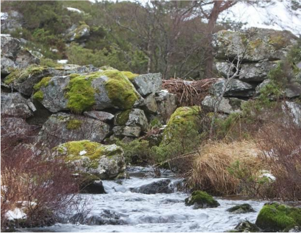
Figur 61. Steindemning mellom Ovadalsvatnet og Barmvatnet. (Foto: privat)
