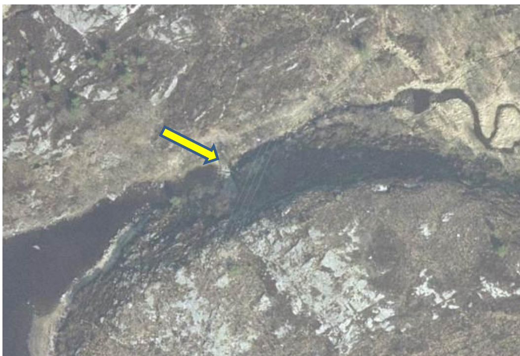
Figur 60. Nylig flyfoto av steindemning (gul pil) mellom Ovadalsvatnet og Barmvatnet. (Kilde: www.webatlas.no )
