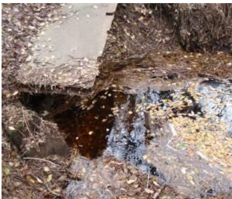
Figur 59. Innløp til kulverten under fotballbanen..
