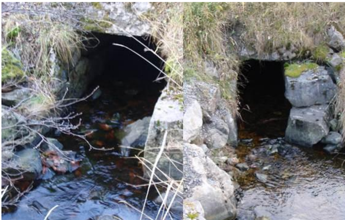
Figur 106. Inn- og utløp av steinkulvert (2) under Fv 381.
