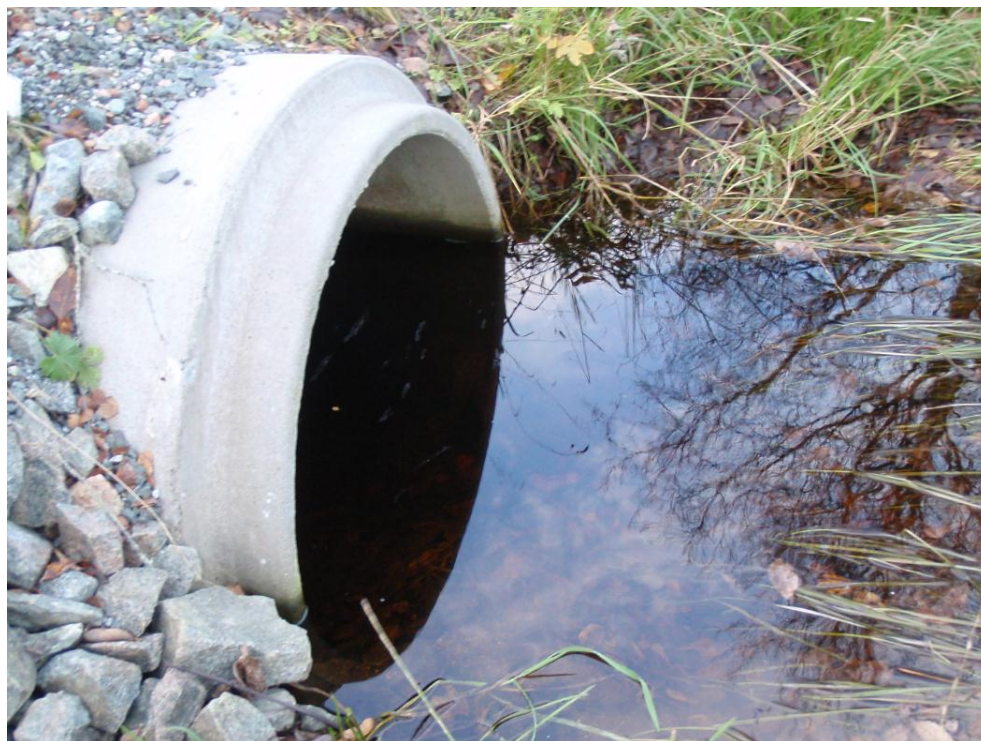
Figur 107. Krysning under grusvei (5) i tilløpsbekken til Hopsjøvatnet.
