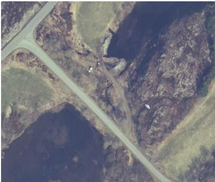
Figur 79. I dag er veifyllinga utvidet og kulverten fjernet, slik at vannet renner tvers gjennom veien og ingen sjørret kan lenger passere. (Kilde: www.webatlas.no )
