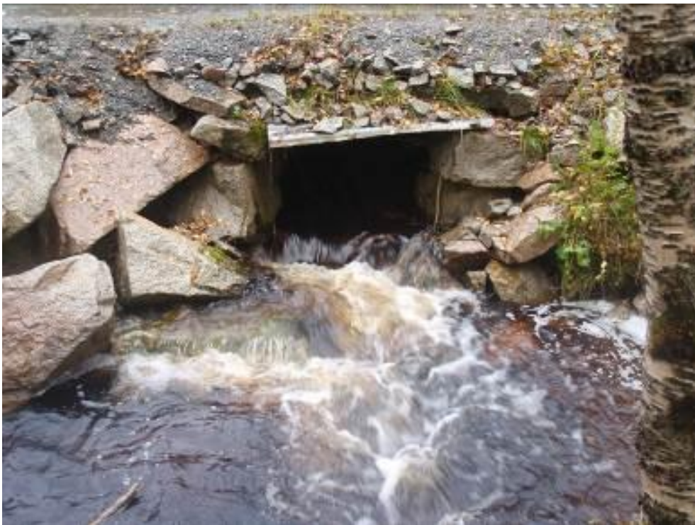
Figur 37. Kulvert under Fv 713 i Dalavassbekken.
