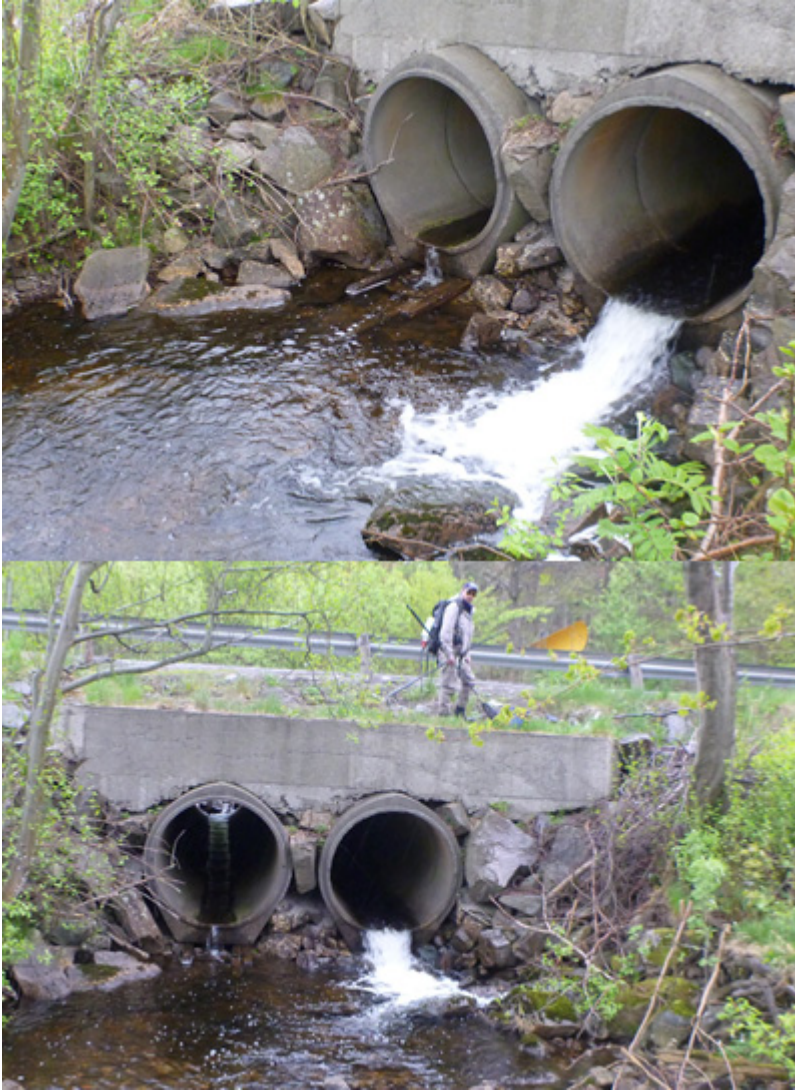
Figur 35. Vandringshindrende kulvert under Torridalsveien. Foto: Karl Jan Aanes.
