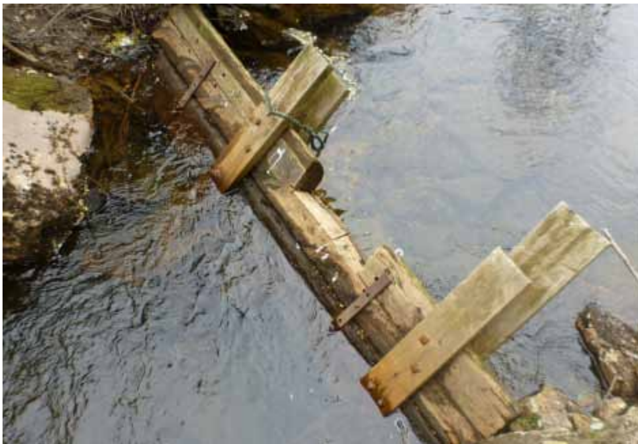
Figur 28. For å heve vannspeilet og senke spranghøyden nedstrøms krysningen under traktorveien, er det satt opp tversgående trebjelker, som får fisketrappfunksjon. Nylig flom har delvis redusert demningsfunksjonen dette ga, slik at tiltaket potensielt ikke fungerer lenger.
