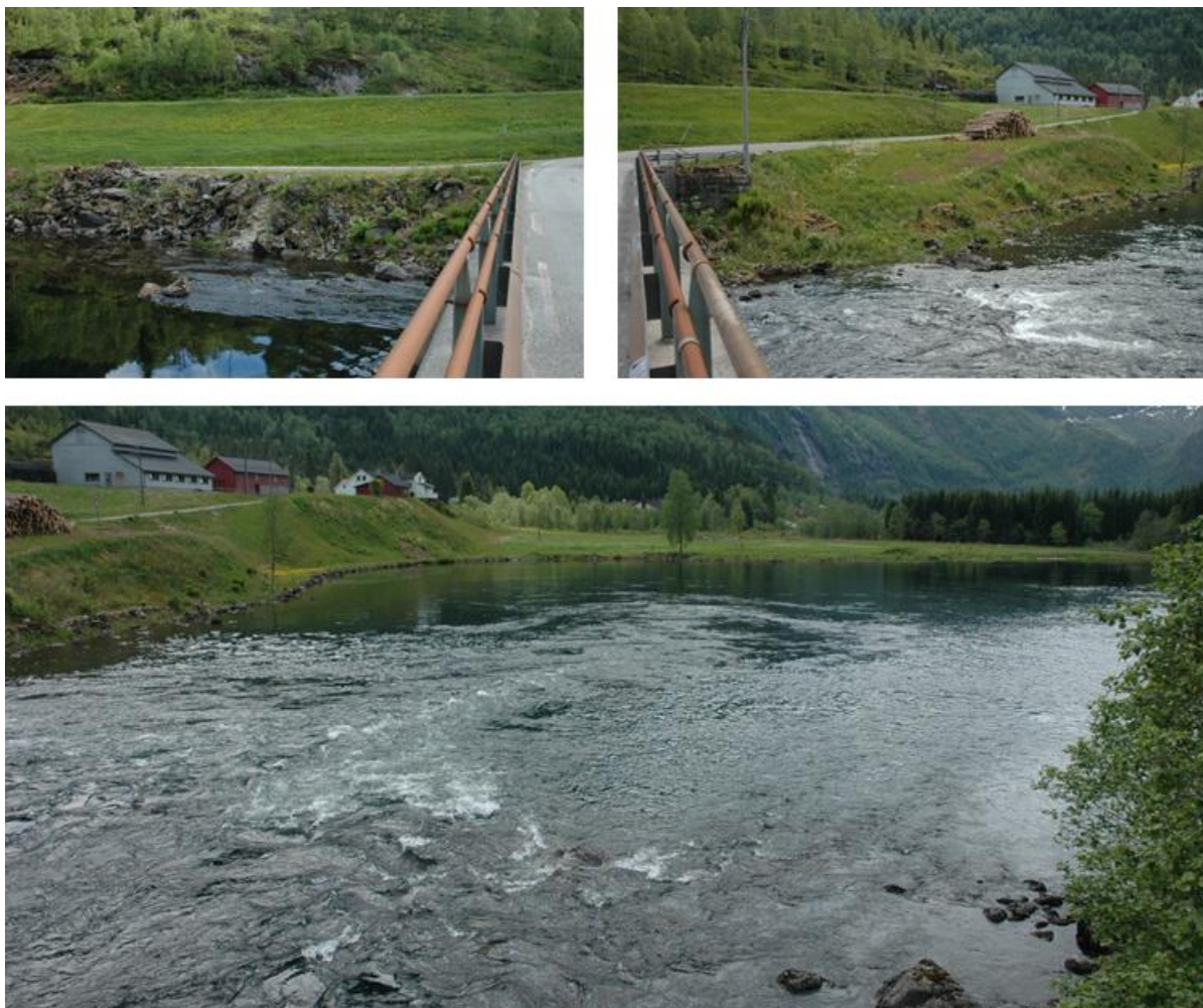
Figur 9. Østsiden av brua over Straume (øverst v. og h.), nedstrøms brua over Straume (nederst).
