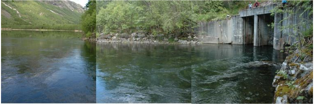
Figur 7. Utløp av Kraftverket ved Steinslandsvatn, bildet tatt mot nord.
