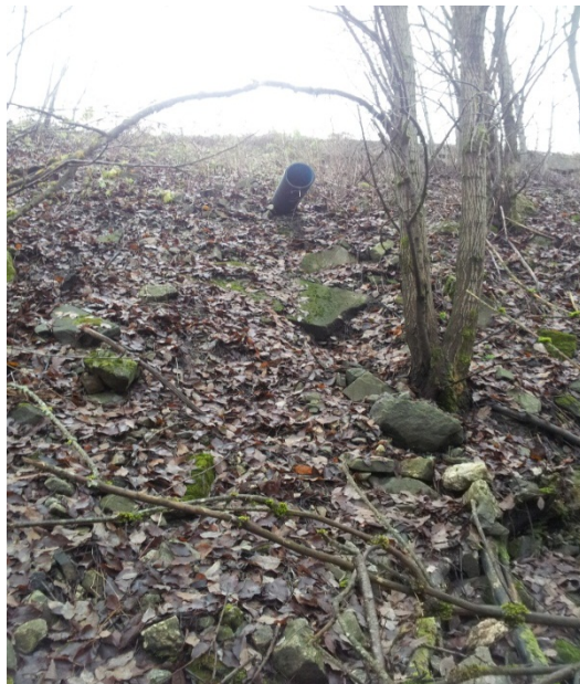
Utløp fra siste sandfang øst mot Gjersrudtjern.
