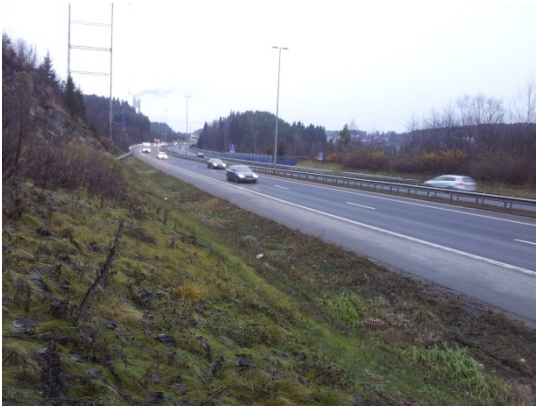
Siste sluk/sandfang før bru vest.
