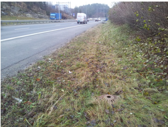
Siste sluk/sandfang før bru øst.
