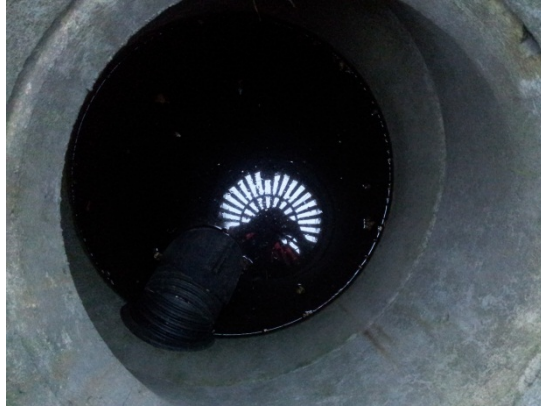
Dykket utløp fra siste sandfang mot bekkenedløp.
