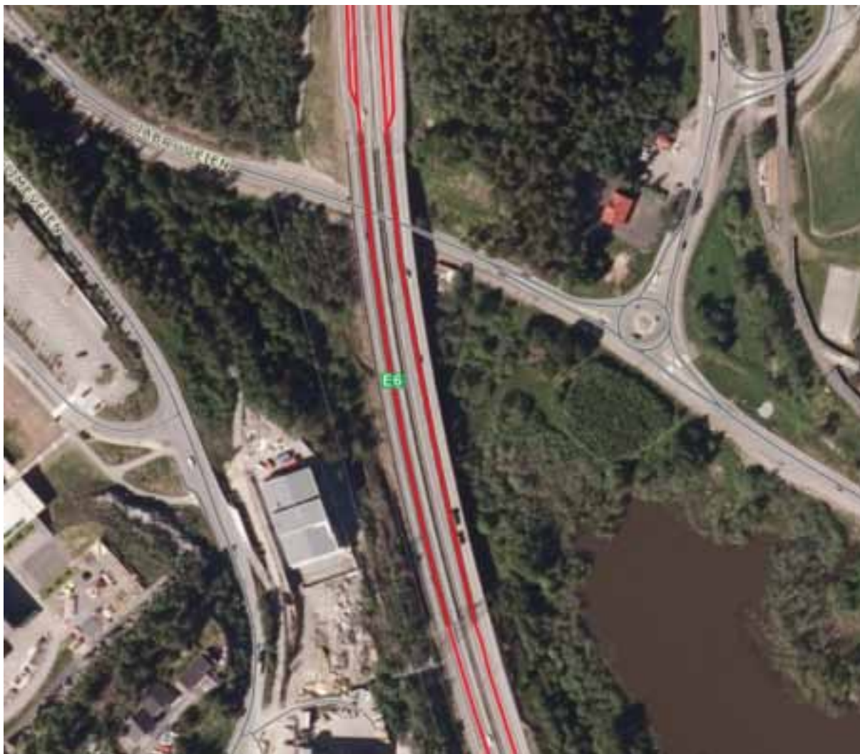
Figur 10. Veianlegg ved nordenden av Gjersrudtjern (fra Norgebilder.no) (se også Figur 1).
