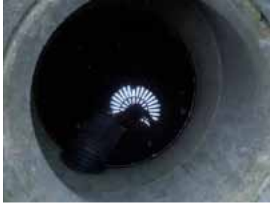
Dykket utløp fra siste sandfang mot bekkenedløp.
