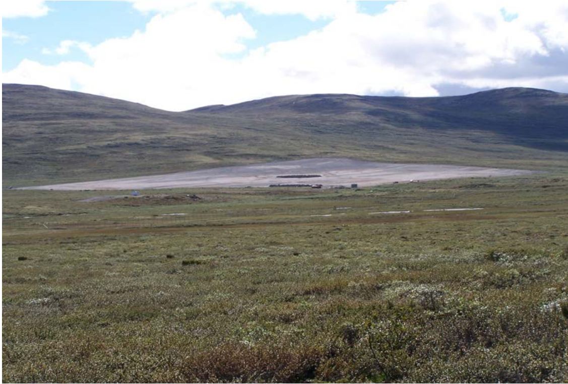
Fig.19. HFK-sletta i Grisungdalen sett mot syd. Den avvannes av to bekker. Den ene (NØ-bekken) er grøftet fra nord-østre hjørnet av sletta (til venstre på bildet), renner langs NØ-kanten av sletta og ender i Grisungbekken ved bilen/bua nær midten av bildet. Den andre bekken (NV-bekken), er større, ikke, grøftet, og starter langt oppe i lia i øvre høyre bildekant, passerer langs nedre del NV-del av sletta (til høyre på bildet) og munner ut i Grisungbekken ved nær det samme sted som den andre bekken.
